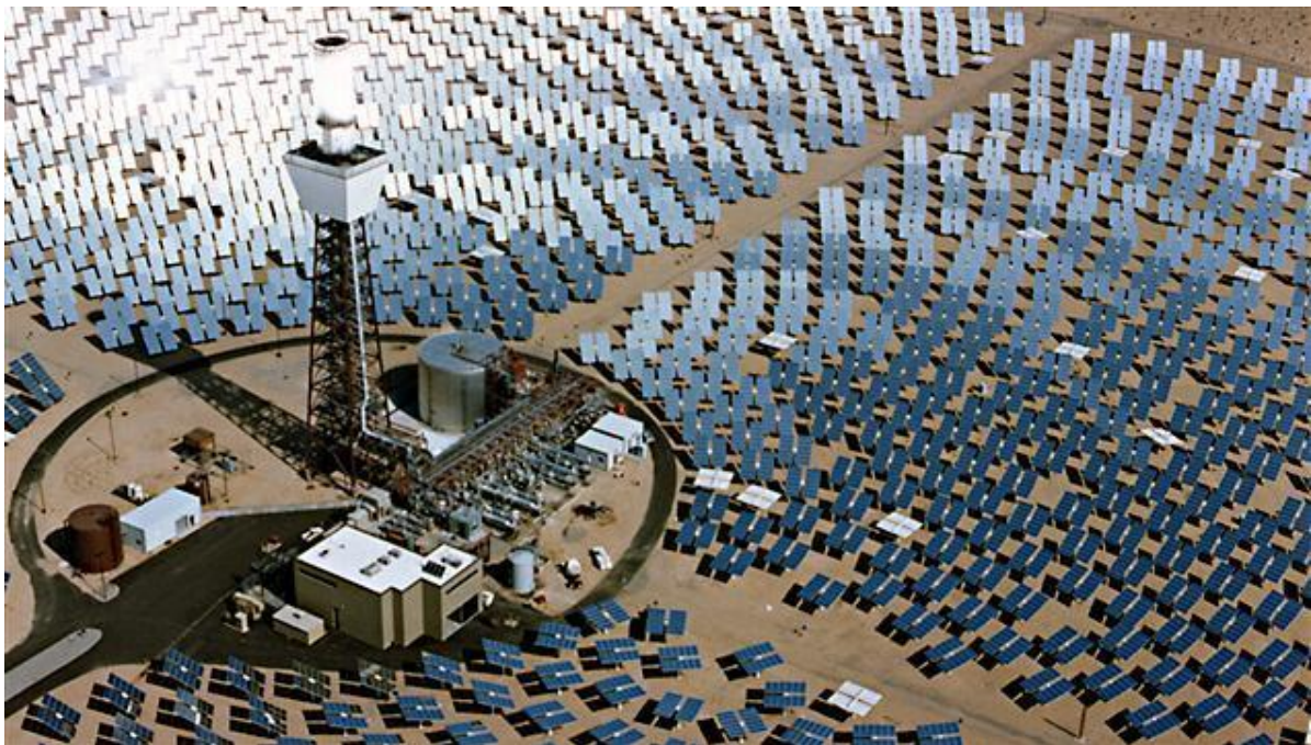
Figure II-3 :centrale solaire à tour (Californie) [25].
