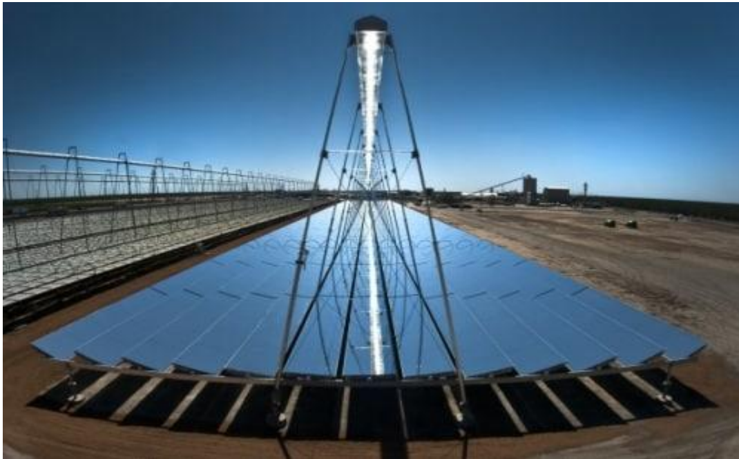
Figure II-9 : Centrale solaire a miroirs de Fresnel.
