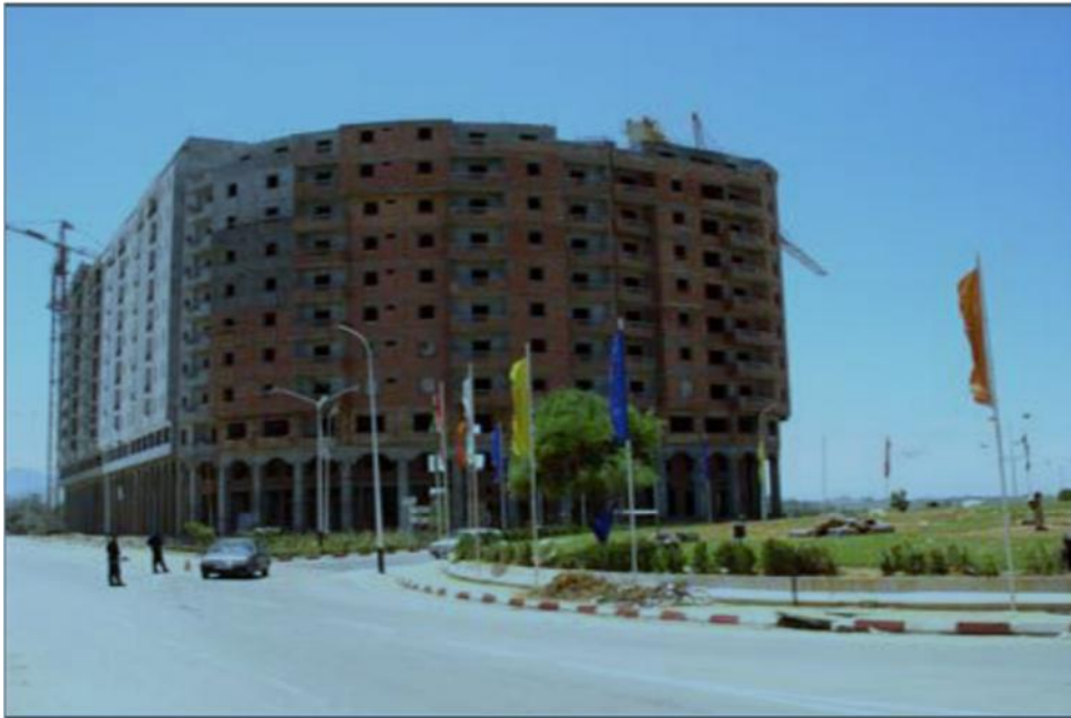
Figure I.16 : Bâtiment en cours de construction dont la sauvegarde est due à la présence des cages d'ascenseur en voile en béton armé (Davidovici 2003).
