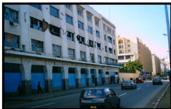
Fig.34: Vue sur la rue H. Ben Bouali, source Auteur
