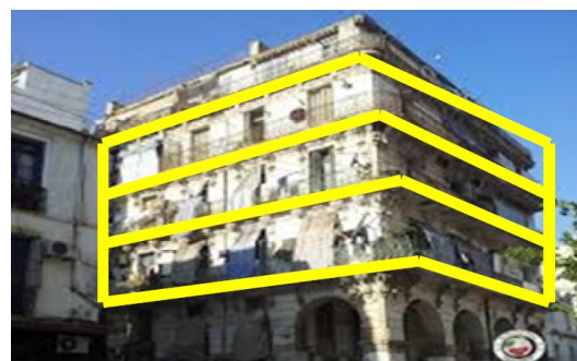
fig.51 : façade de style néoclassique Source : Auteurs
