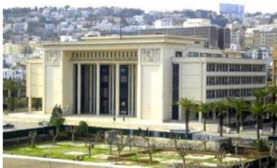
Fig.46 : Place de l'UGTA, source : auteurs
