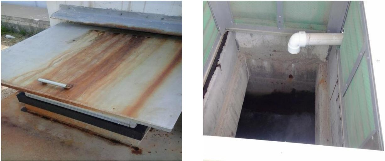
Figure 12 : Cuve de contact pour la post-chloration
