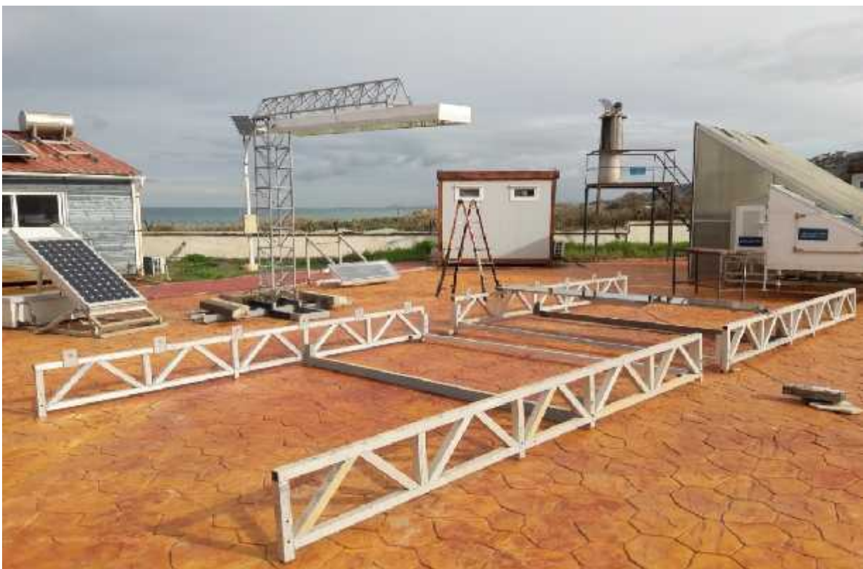
Figure IV.24 : mise en place du notre récepteur thermique
