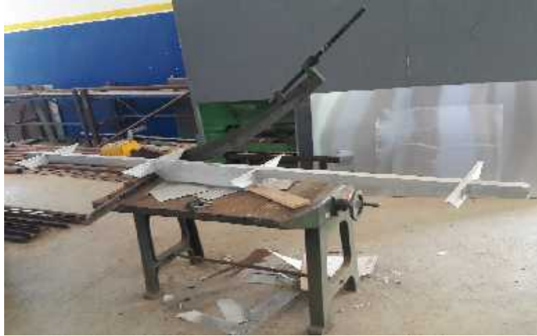
Figure IV.10 : Différentes étapes pour la construction des lignes pour supporter les miroirs
