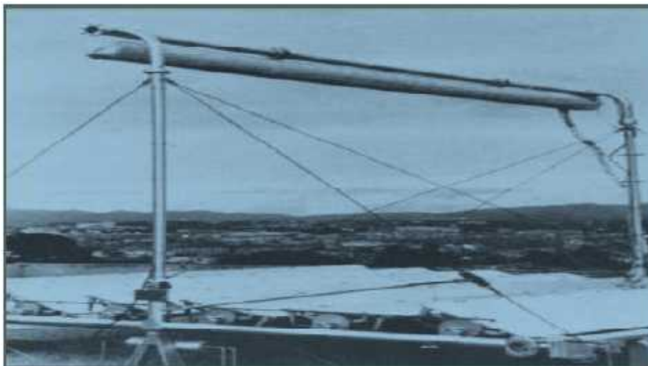
Figure I.08: Premier prototype de Concentrateur Linéaire de Fresnel, Marseille (France) 1963 [5].
