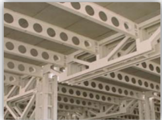
Fig. 108: poutre alvéolaire. Source : cour structure m2.
