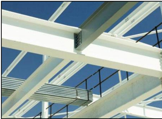
Fig. 113 : Système d'articulation de deux poutres Source : http://detailsconstructifs.cype.fr
