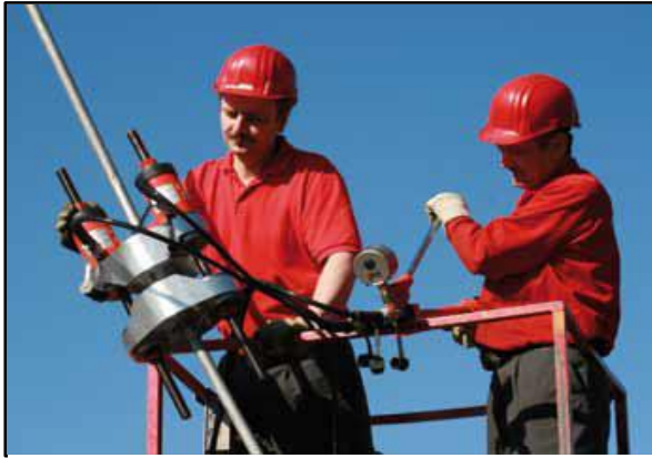
Fig. 133 : la liaison des tirants Source : www.halfen.fr
