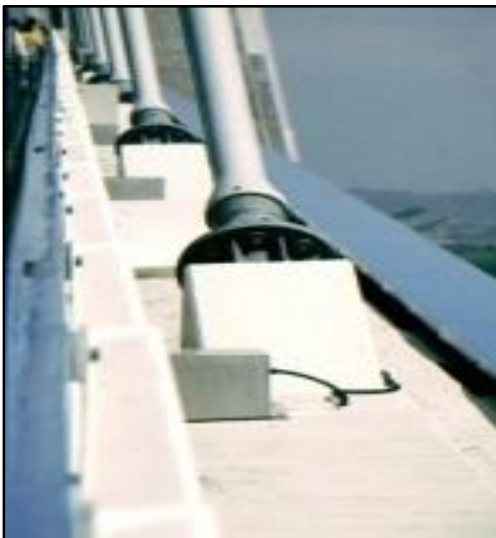
Fig. 132 : l'encrage d'un tirant avec la structure Source : www.gramme.be/unite9/Haubans
