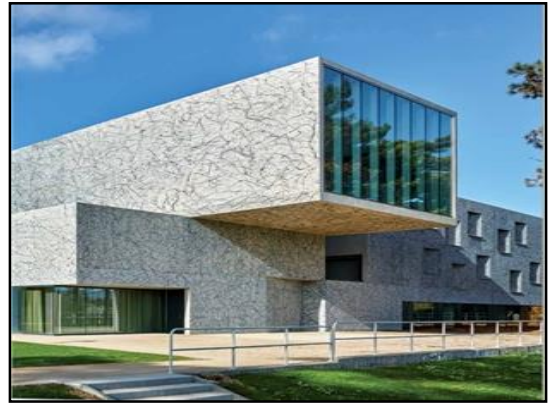
Fig. 15: Construction moderne. Source : http://www.vivreenbelgique.be
