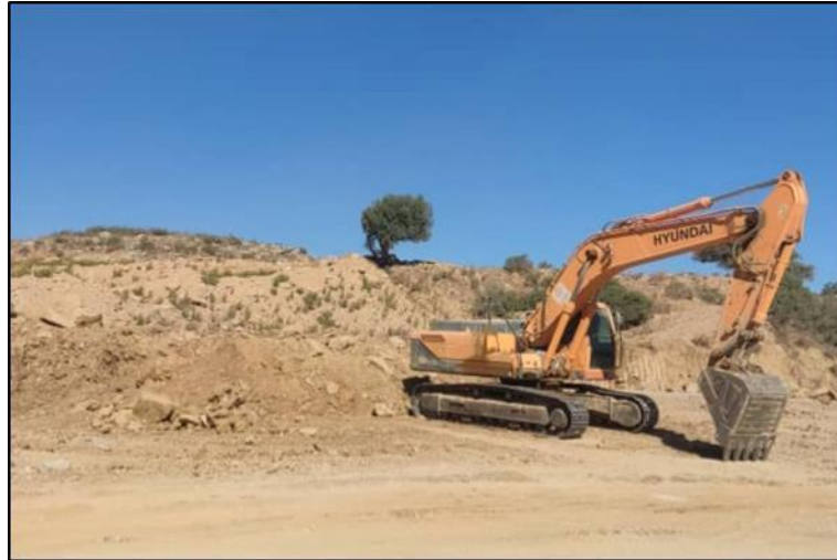
Figure 16 : photo montrant la découverte marneuse à blocs et le couvert végétal
