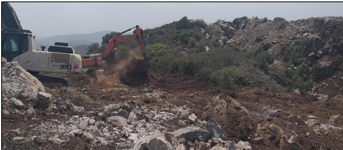
Figure 35 : Travaux de décapage, Pelle entrain d'enlever la découverte
