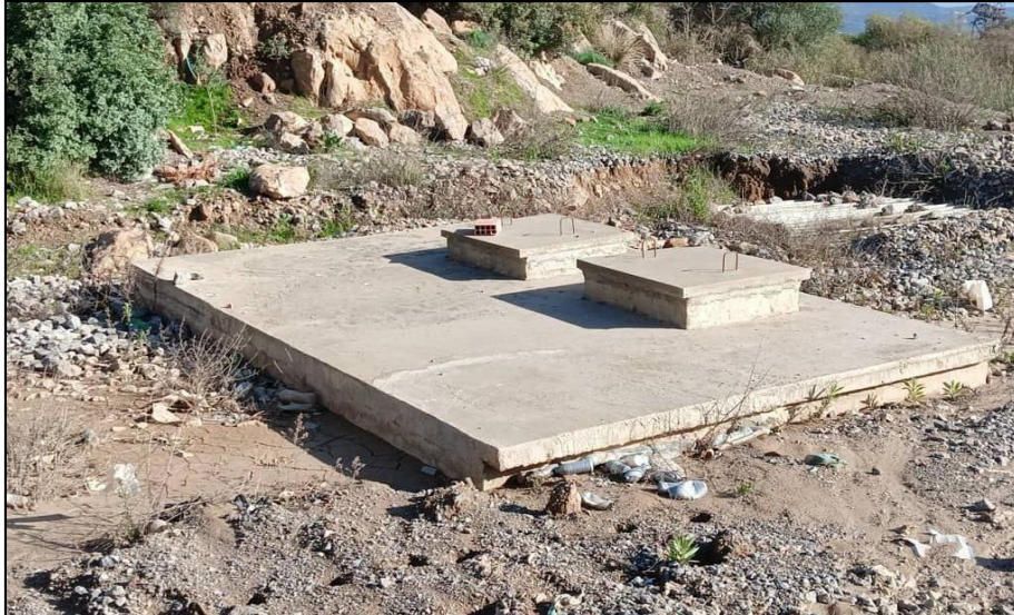
Figure 58 : Bassin de décantation appartenant à Cosider C35
