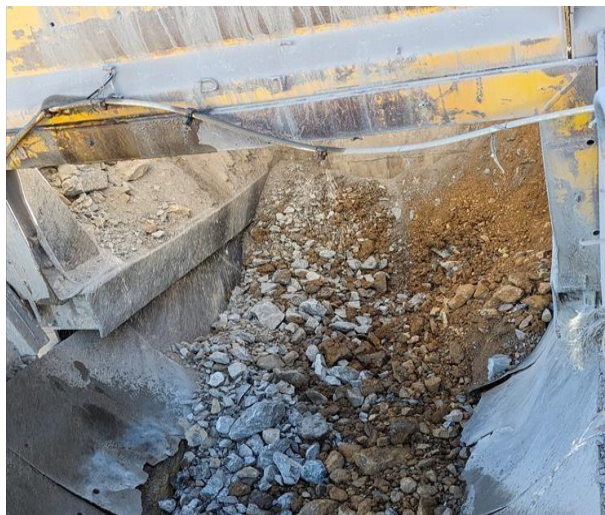
Figure 62 : Aspersion d'eau au niveau de l'entrée du concasseur à mâchoires
