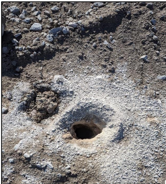
Figure 37 : Un trou de mine
