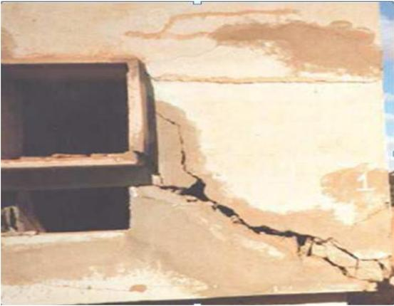
Figure I.9 : Fissure sur les murs et Fissures diagonales (Derriche Z et al.2002).
