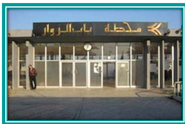
Figure 91: la gare du Bâb Ezzouar
