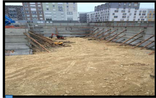
Figure153: mise en œuvre d'un voile. source: Auteur
