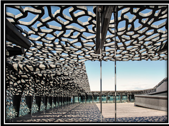
Figure 177 :couverture perforée en béton résille Source : http://www.ductal.com
