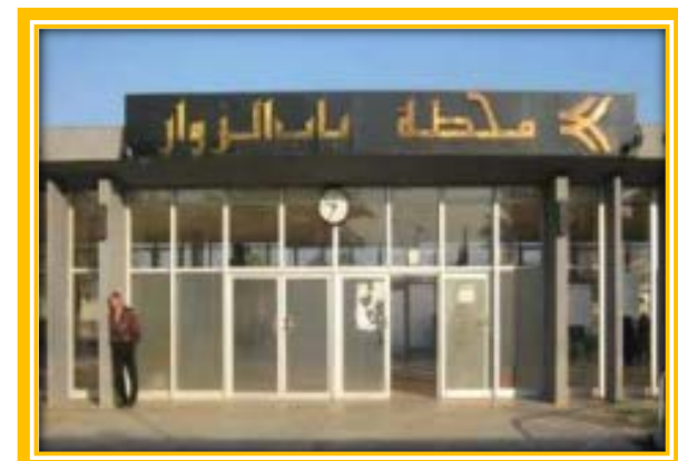
Figure 66 :La gare du Bâb Ezzouar
