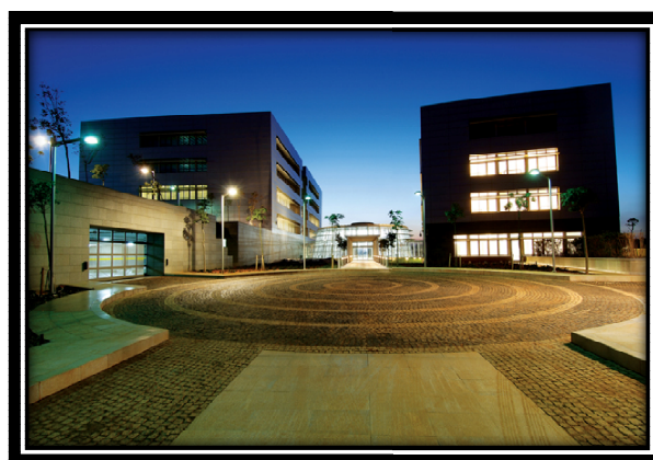
Figure 102 : vue de l'entrée vers l'incubateur source : http://www.adrogres-ssidabdalhhe.com .
