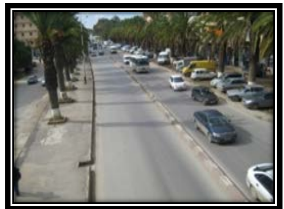
Figure 55 : la voie RN24 source : auteur
