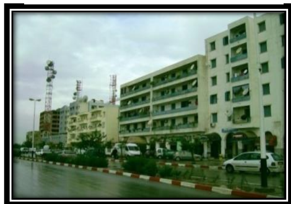
Figure 75 : cite 1200 log (style moderne) source :photo prise par l'auteur
