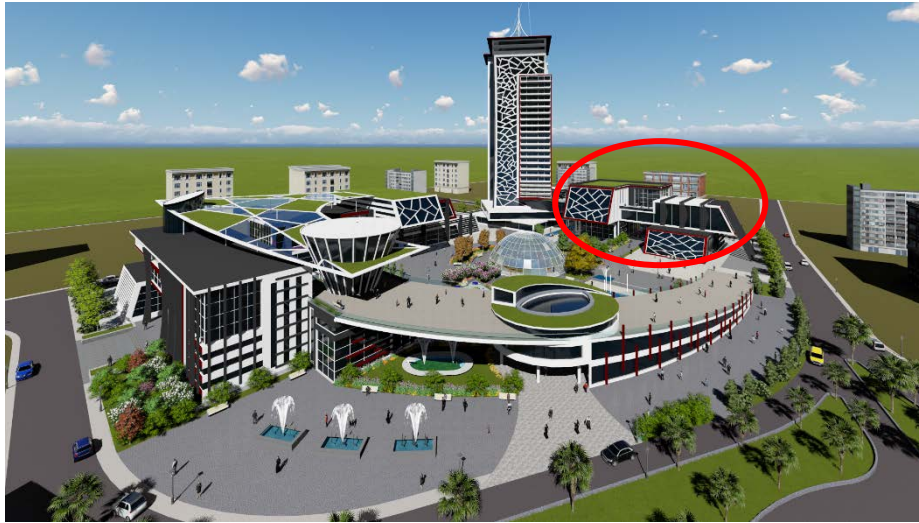
Figure 140: vue sur l'entité étude recherche et formation. source : Auteur.
