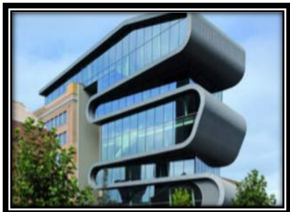
Figure 179 : office building, hoboken (BELGIQUE) Source : Google image
