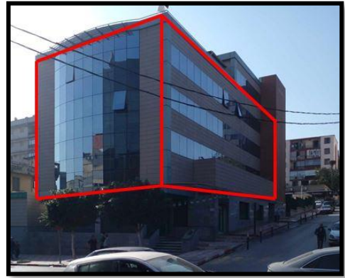
Figure I.143: vue sur les façades de la BNA source : les auteurs
