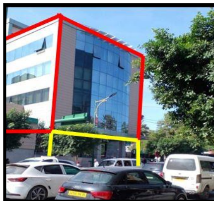
Figure I.142: vue sur la BNA source : les auteurs
