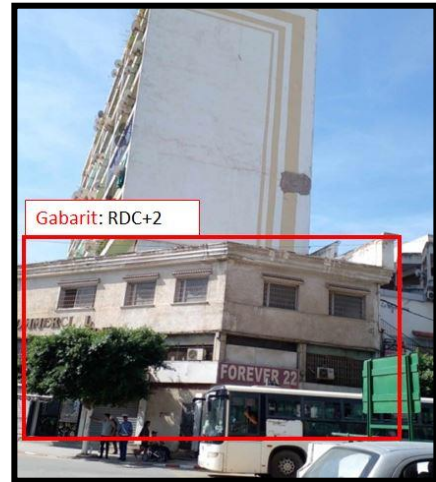
Figure I.157: vue sur le centre commercial Djurdjura source : les auteurs
