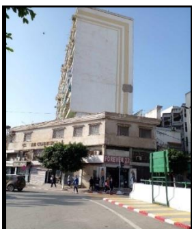
Figure I.113 : Vue sur la paroi 4 (bâtiment Djurdjura) source : les auteurs, 2024
