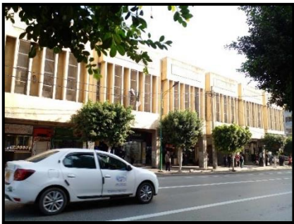
Figure I.117 : Vue sur la paroi 2 (bâtiment cheikh) source : les auteurs, 2024
