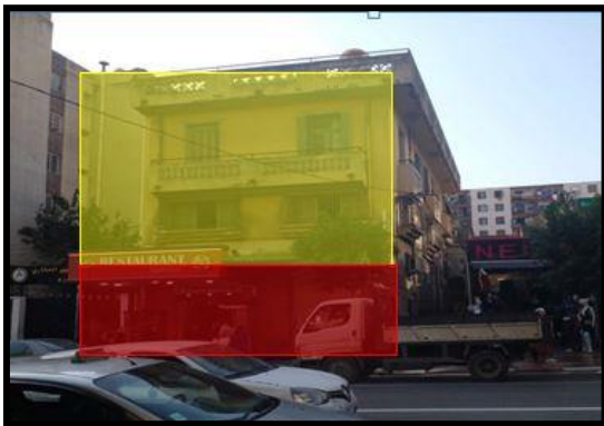
Figure I.145: vue sur l'immeuble d'habitations coloniale, source : les auteurs
