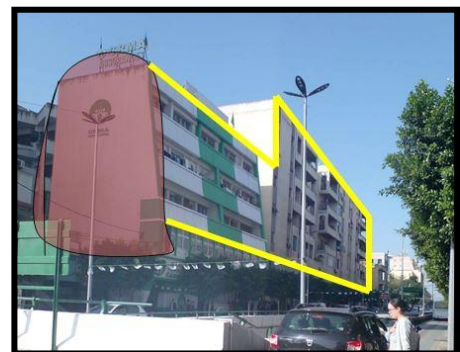
Figure I.155: vue sur la façade de la CRMA source : les auteurs
