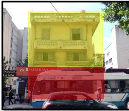
Figure I.148: vue sur l'immeuble d'habitations coloniale source : les auteurs
