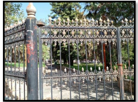
Figure I.185: vue sur le jardin de 1 er novembre source : les auteurs
