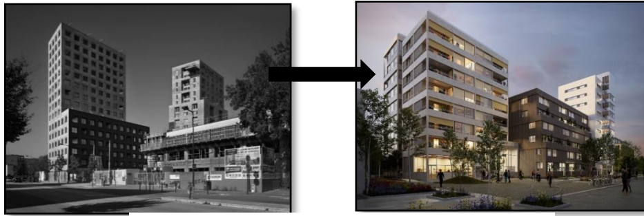
Figure II.10: nouveaux bâtiments mixtes après la requalification source : www.google-image.com
