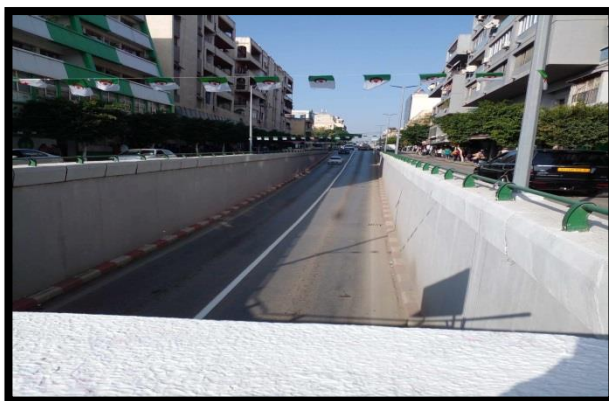
Figure I.57: vue sur la trémie source : auteurs
