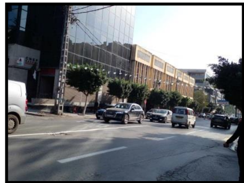
Figure I.140: vue sur la façade de la CNEP source : les auteurs
