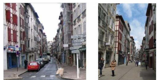
Figure II.19: rénovation des façades source : www.iledenantes.com
