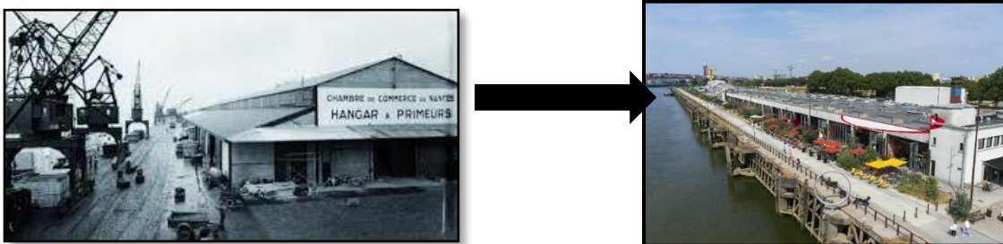
Figure II.11: Le hangar a banane avant et après la requalification source : www.google-image.com
