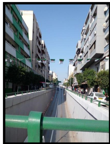
Figure I.56: vue sur la trémie source : auteurs
