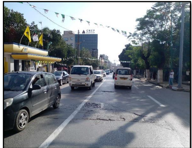
Figure I.84 : vue sur le 2èm tronçon de l'avenue AR source : les auteurs, 2024
