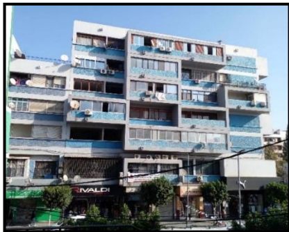
Figure I.118 : Vue sur la paroi 1 (bâtiments bleu) source : les auteurs, 2024
