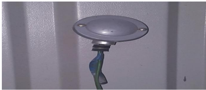
Figure 1.9.1. Sonde de température
