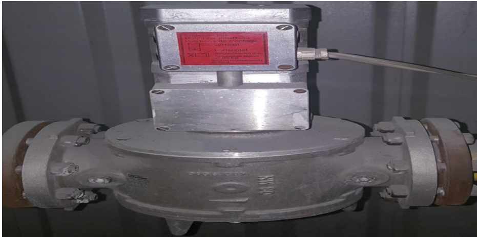
Figure1.22. Soupape de limite
