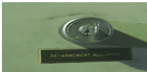
Figure 1.13.4. Contacteur à clé.
