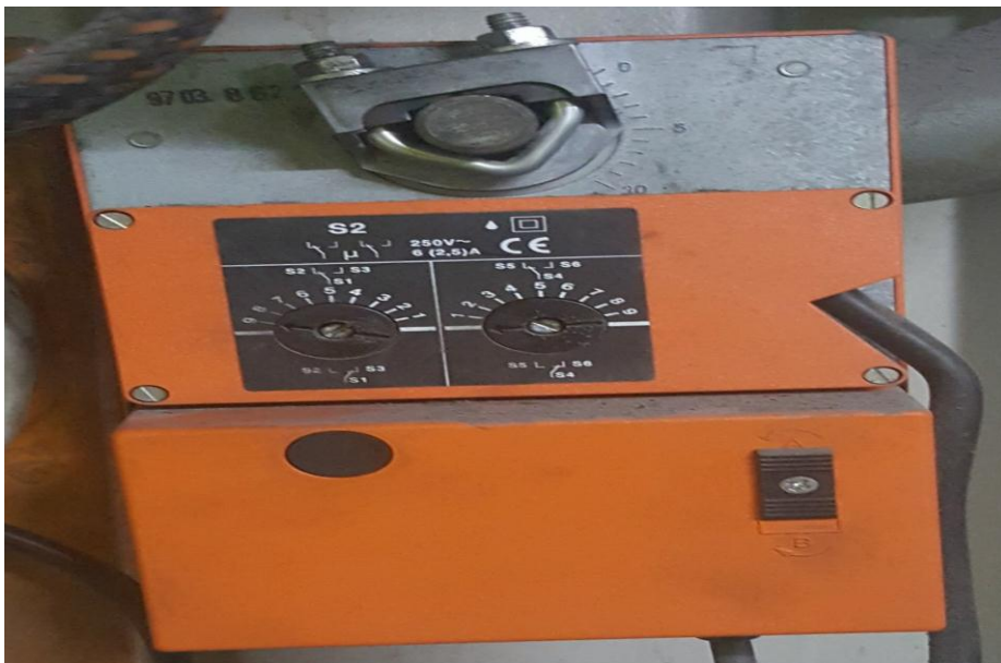
Figure 1.21. Vanne à papillon (vanne motorisé)
