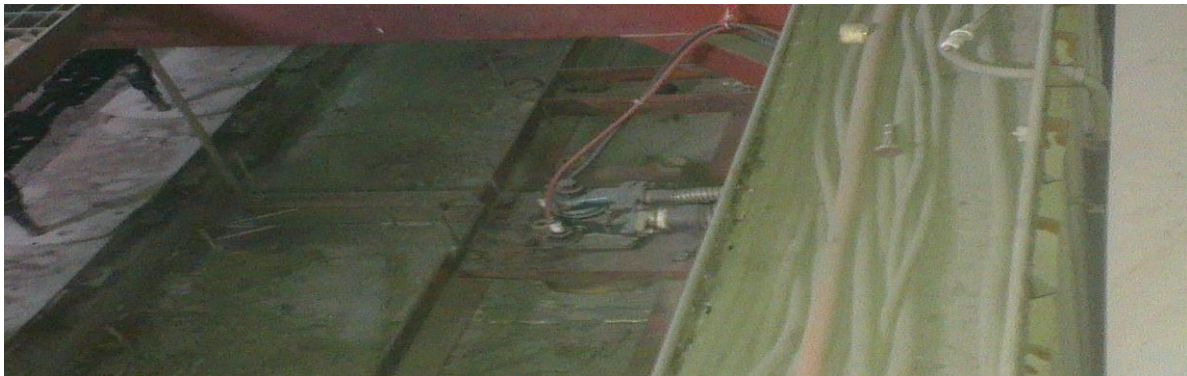
Figure.1.19. L'emplacement d'un bruleur sur le toit du four
