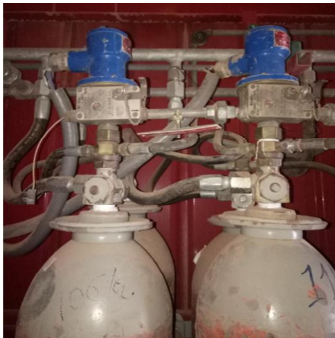
Figure I.6: Les têtes des électrovannes bouteilles pilotes
