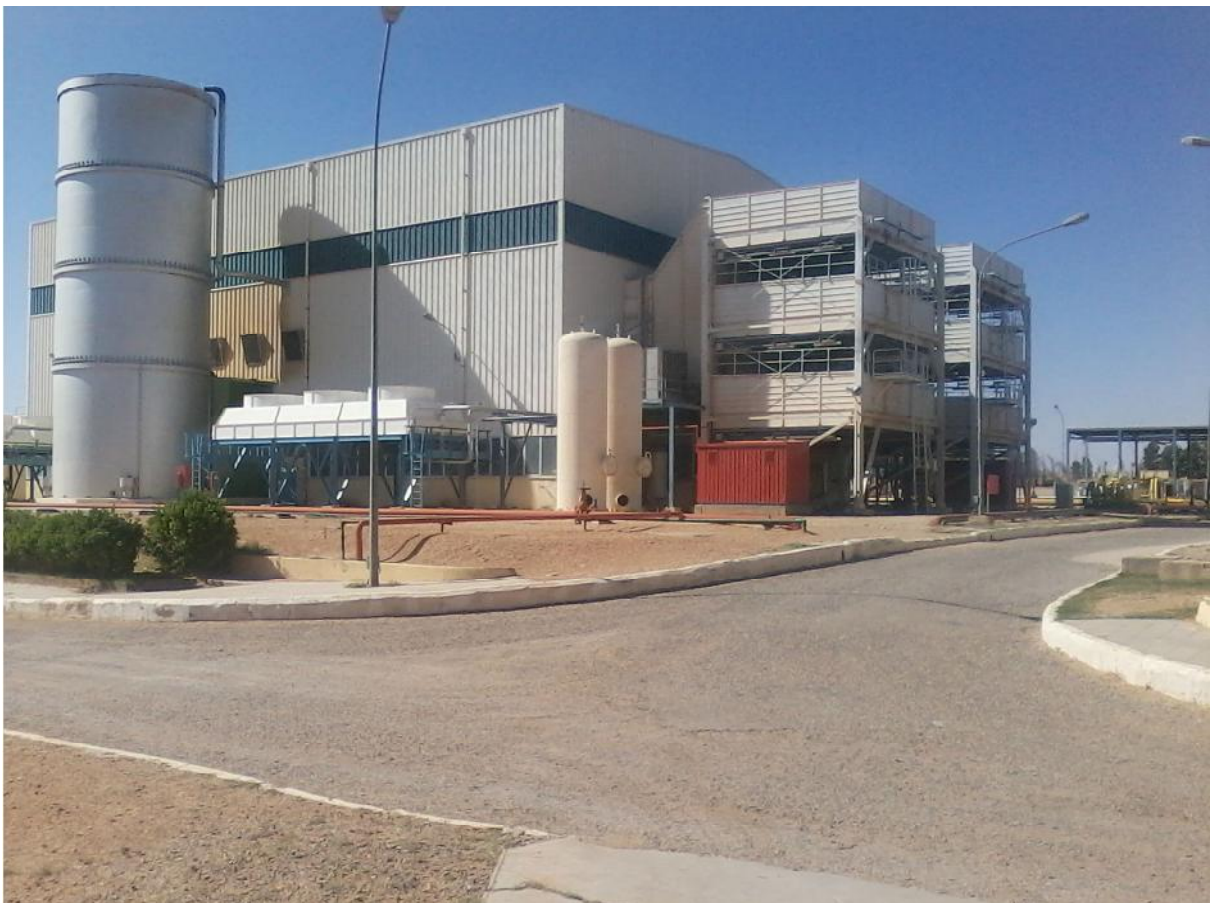
Figure I.2 : Vue générale de la centrale TILGHEMT
