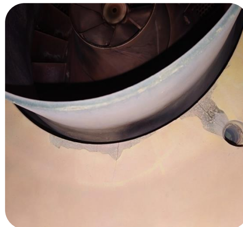
Arrachement du revêtement, fissures Légères et décoloration
