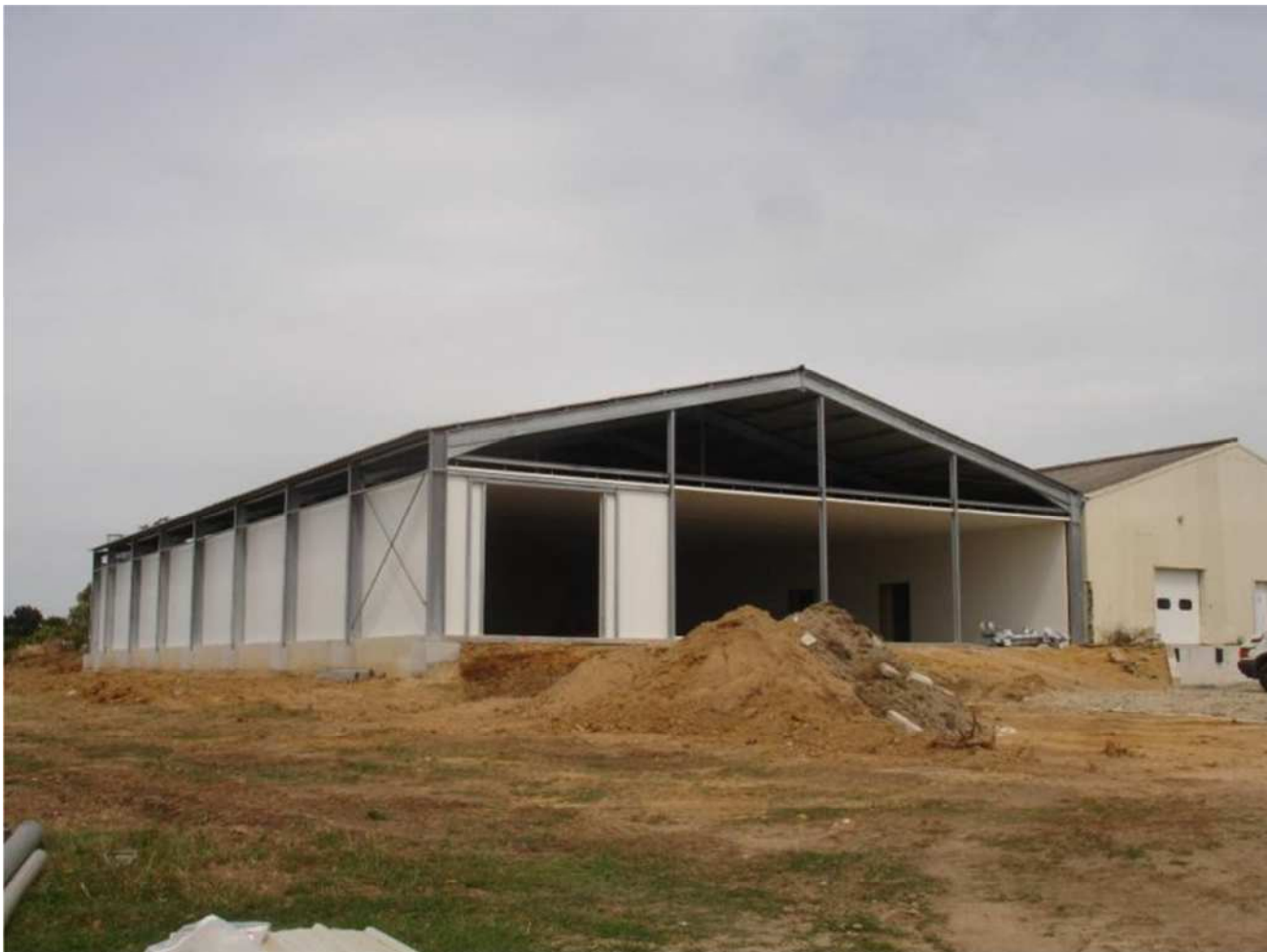
Fig 15-I- Charpente métallique + bardage en panneau sandwich
