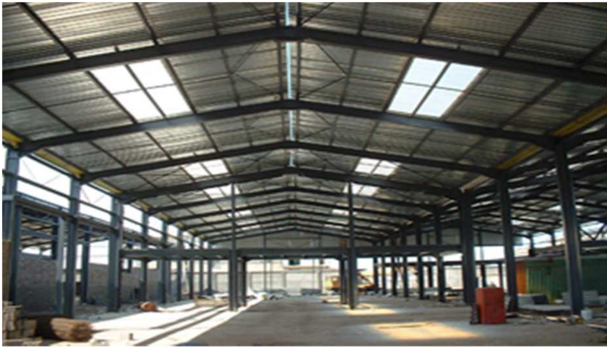
Fig 14-I- Hangar avec une charpente métallique
