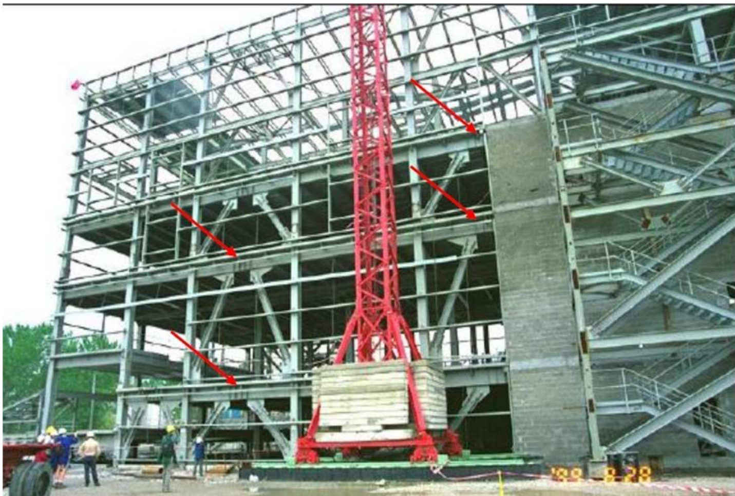
fig19-I- Bâtiment avec triangulation excentrée en cours de construction (USA)
