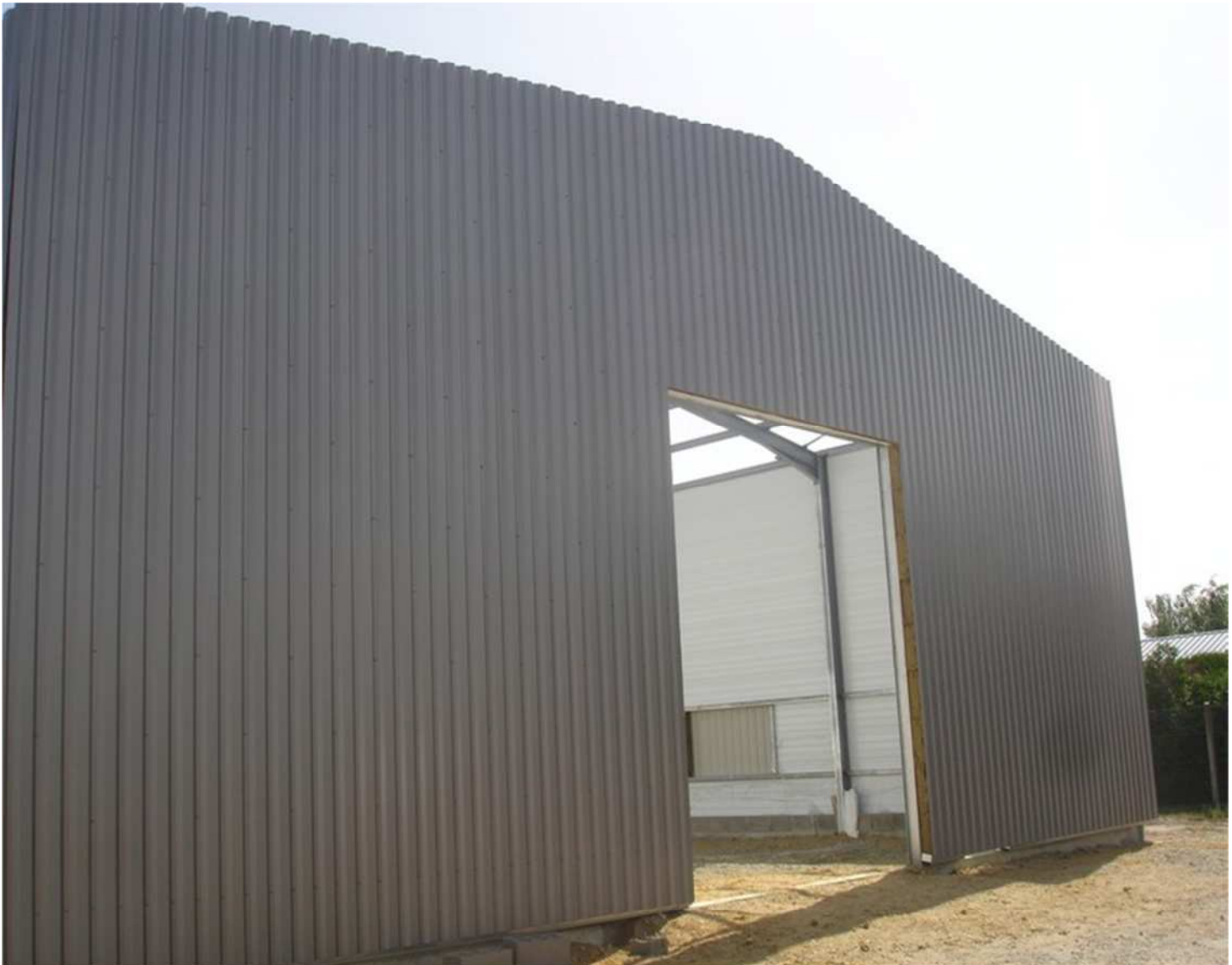
Fig 12- I -Bardage par panneaux sandwich
