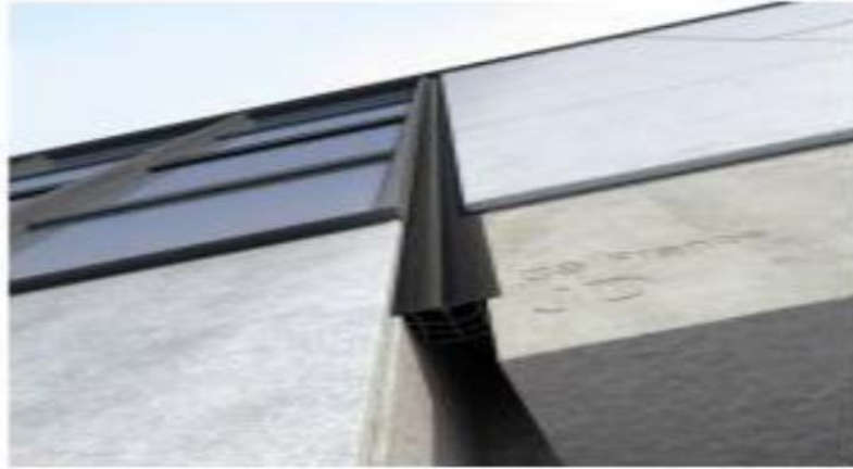
Figure I. 7: Un joint parasismique entre deux bâtiments [3].
