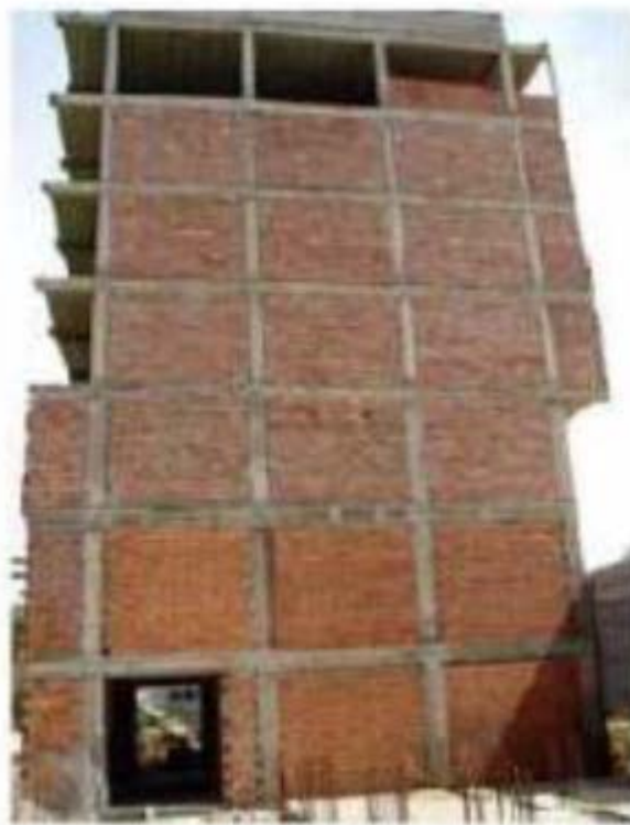
Figure I. 1: Ossature contreventée par portique auto stable [3]
