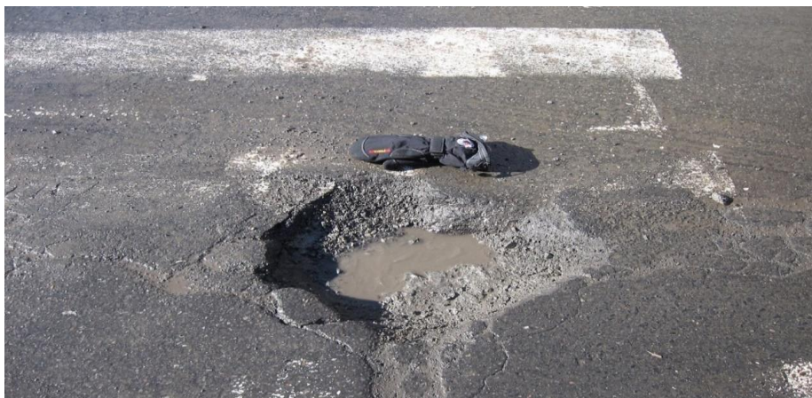
Figure I.15. Nid de poule a Villeray, Canada. (Tremblay, 2007).
