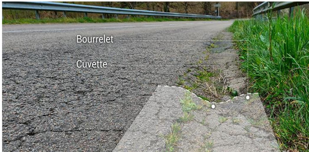
Figure I.9. Affaissement de rive (Dal Pos, 2020).
