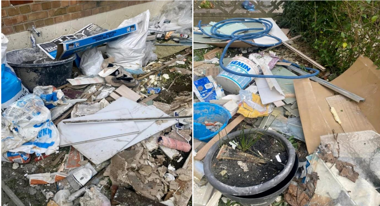
Figure II.4. Déchets de construction.
