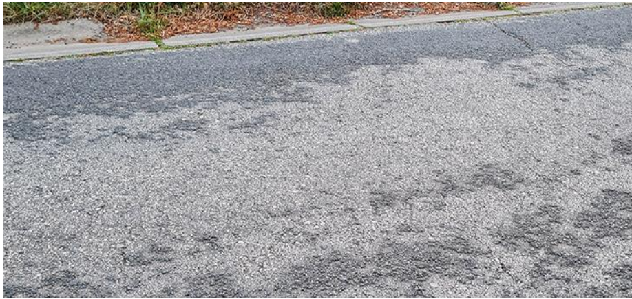
Figure I.16. La pelade (Dal Pos, 2020).
