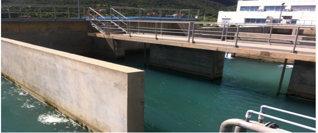
Figure 05 : Ouvrage de répartition d'eau
