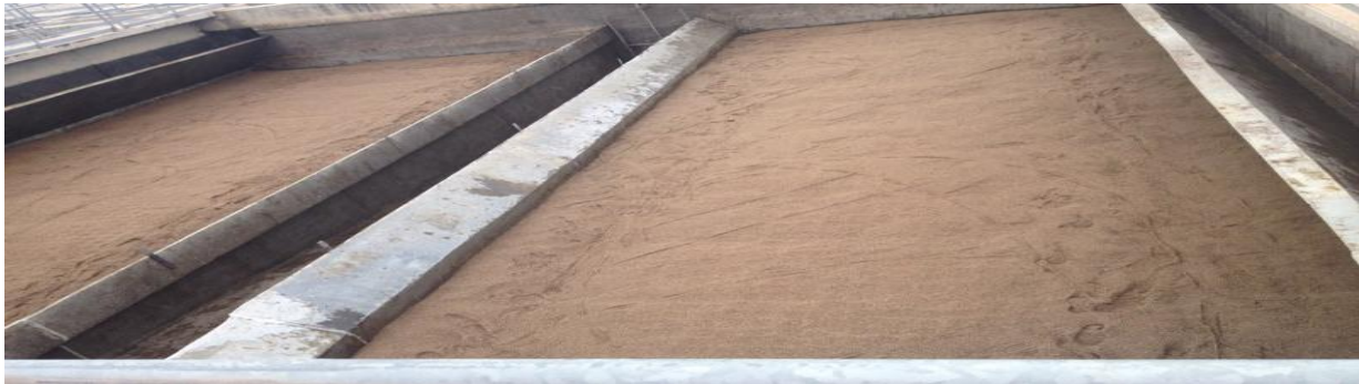
Figure 08 : Traitement des boues
