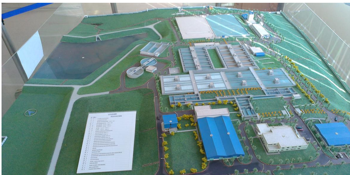
Figure 03 : Station de traitement Taksebt
