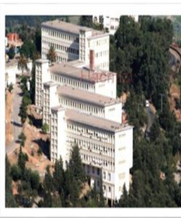
Photo 07 : Sanatorium (source : Google images).
