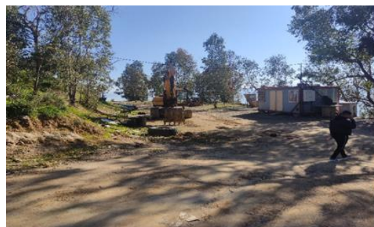
Photo 32 : vue des travaux dans la forêt récréative (source : auteur).
