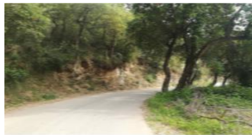
Photo 22 : (2) vue sur piste 02 (source : auteur).
