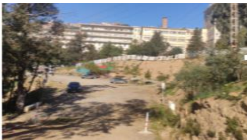
Photo 21 : (1) vue sur piste 01 (source : auteur).
