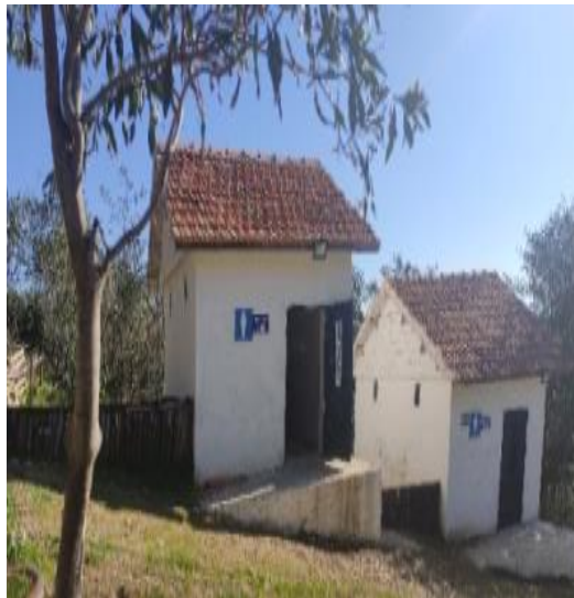
Photo 37 : vue sur les WC de la forêt récréative (source : auteur).
