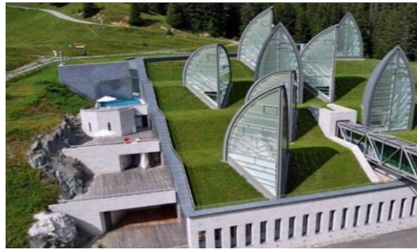
Photo 61 : Vue sur l'intégration de projet, source : Pinterest site.
