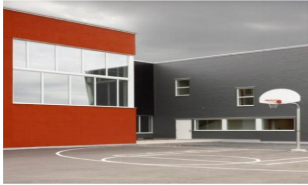
Photo 59 : vue sur le centre, source : fre.architecturaldesignschool.com
