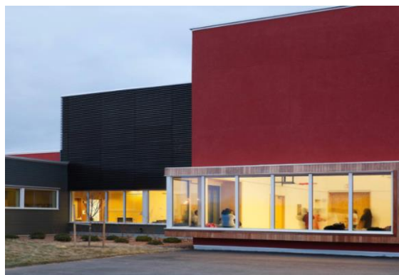
Photo 58 : vue sur le centre, source : fre.architecturaldesignschool.com
