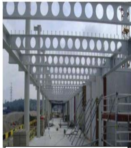
Figure 96 : poutres alvéolaires Source : google image
