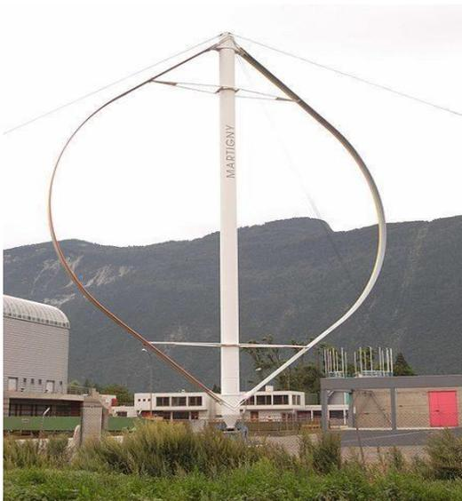
**Figure 1.5 :** Eolienne de type Darrieus.
