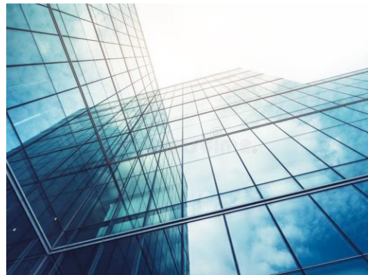
FIGURE 139: LE VERRE DANS LA CONSTRUCTION. SOURCE : GOOGLE IMAGE.
