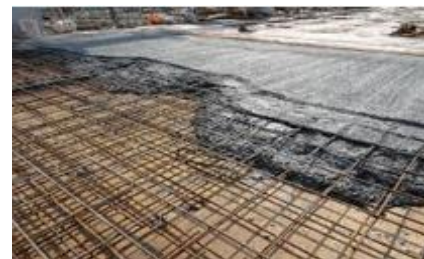
FIGURE 29: LE BETON ARME. SOURCE : GOOGLE IMAGE.
