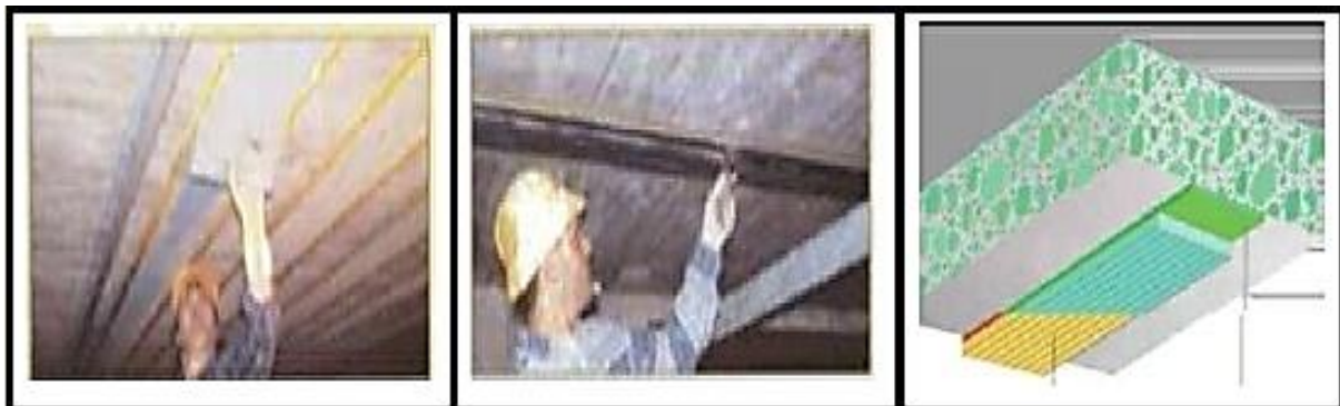
Figure VIII-VI : Procède Par Collage De Plaques (SIKA, 1996).
