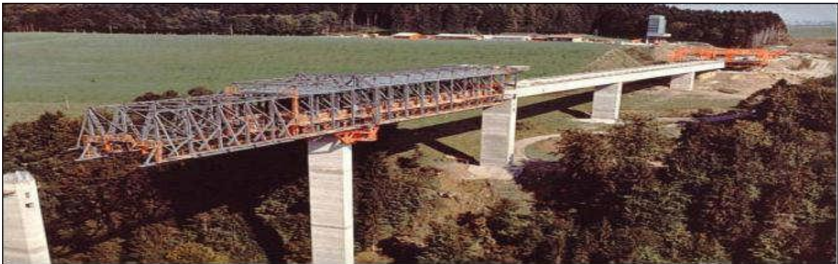
Figure II-IV : Construction par poussage
