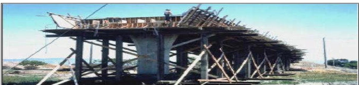
Figure II-V : Tablier coulé sur cintre
