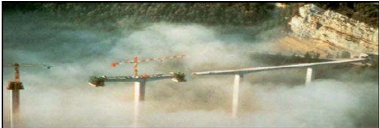
Figure II-VI : Construction par encorbellement
