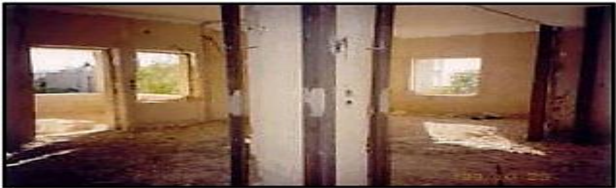
Figure VIII-VII: Renforcement De Poteaux Au Moyen De Profiles Métallique.
