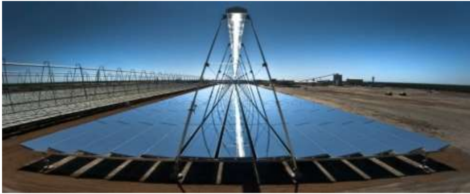
Figure III.01 : Concentrateur linéaire de Fresnel.
