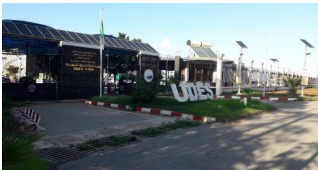
Figure V.01 : Unité de développement des équipements solaire.
