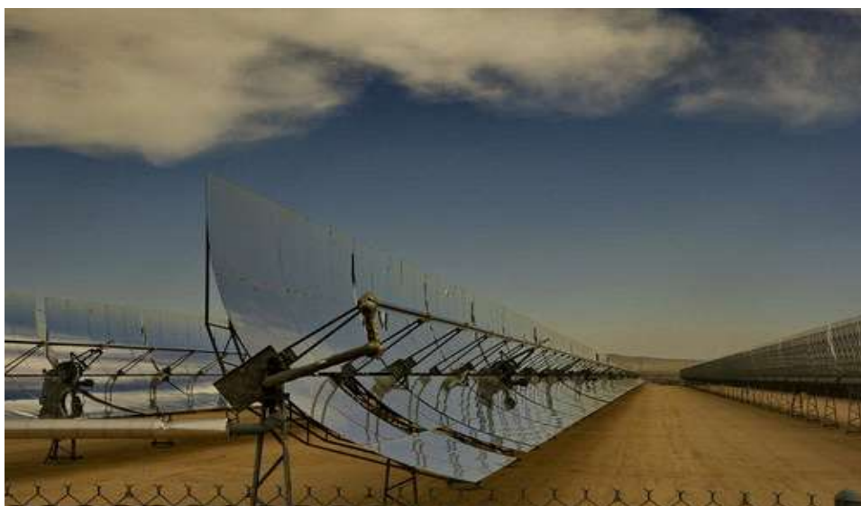
Figure II.07 : Concentrateur à capteur cylindro-parabolique.
