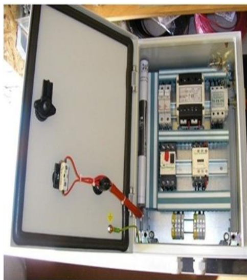
Figure III.1 – représentation d'une armoire de commande
