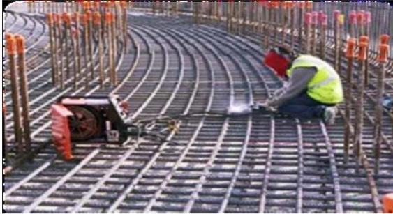
Fig.91 Ferrailage du radier.
