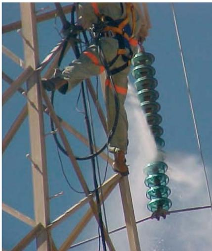
**Fig.III.2 Lavage sous tension**
