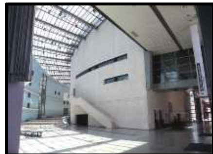
Figure 189: la transparence créée par l'éclairage zénithal
