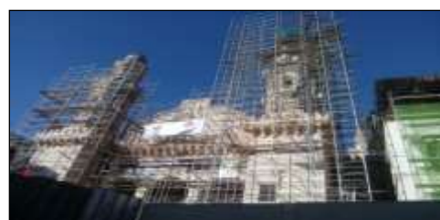
Fig. 13 : réhabilitation, mosquée Ketchaoua Alger Source : Photo prise par l'auteur
