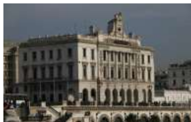
Figure 172: Chambre du commerce
