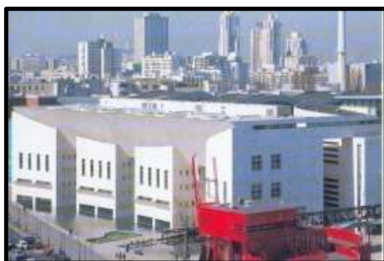
Figure 185: Vue sur l'aile ouest de la cité de la musique
