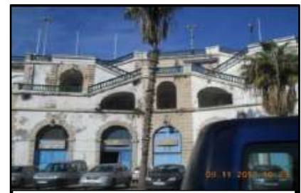
Fig.92 Escaliers et passerelles Source : Auteur
