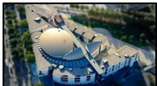
Figure 181: Vue sur l'aile est du cité Source/ http://www.citedelamusique.fr
