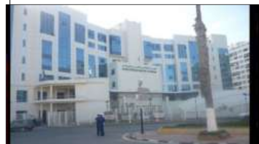
Fig.63 Le conservatoire Source : Auteur
