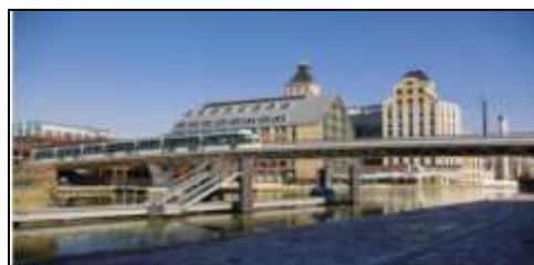
Fig.12 : Reconversion des grands moulins de Pantin en pôle tertiaire Source : http://reconversion.fr
