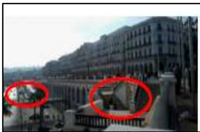
Fig.90 Vue des escaliers urbains Source : Auteur
