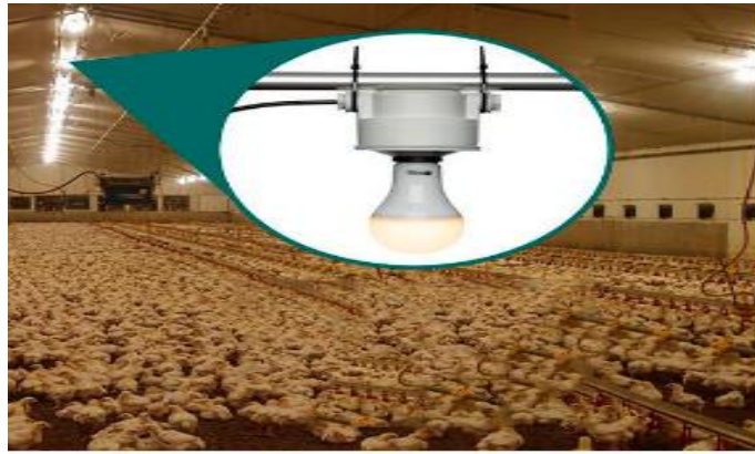
Figure I.10: Système d'éclairage pour bâtiment d'élevage.
