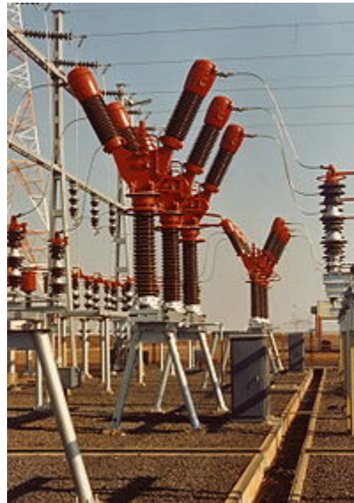
Figure I-17 Disjoncteur à faible volume de l'huile
