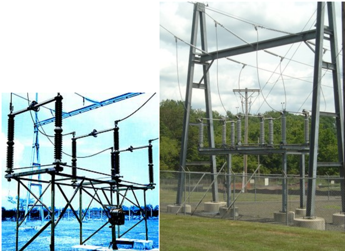
Figure I-16 Sectionneur à moyenne tension
