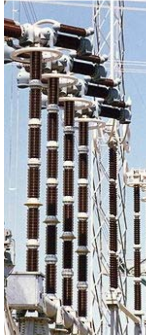
Figure I-18 Disjoncteur à air comprimé
