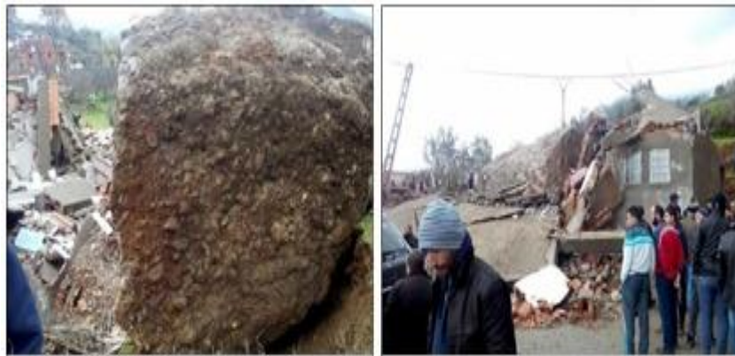
Figure I.9 : Destruction de deux habitations par l'éboulement de mars 2016 Tizi N'Berbère (Béjaïa).
