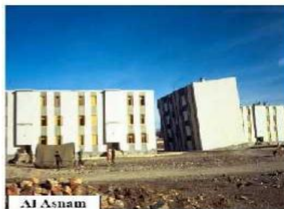
Figure III.5 : Phénomène de liquéfaction.
