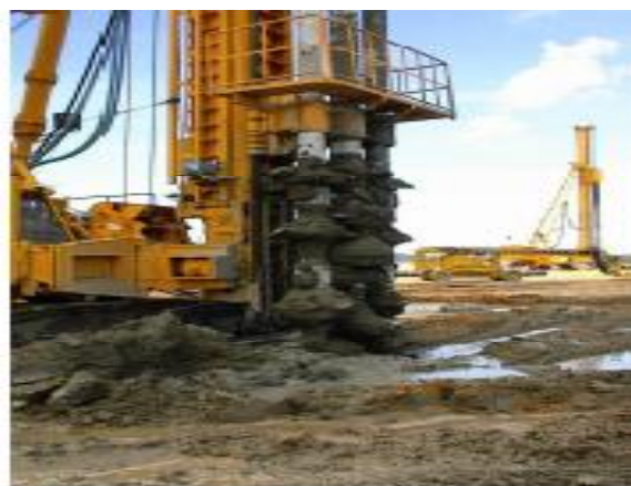
Figure I.7 : Types d'équipement utilisés contenant trois tarières chevauchantes.
