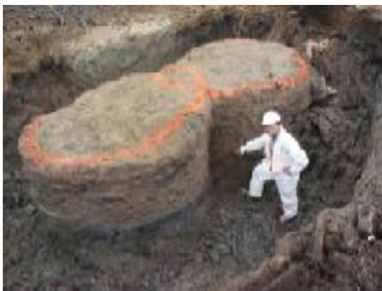
Figure I.8 : Schéma illustrant les colonnes chevauchantes stabilisées de DSM.
