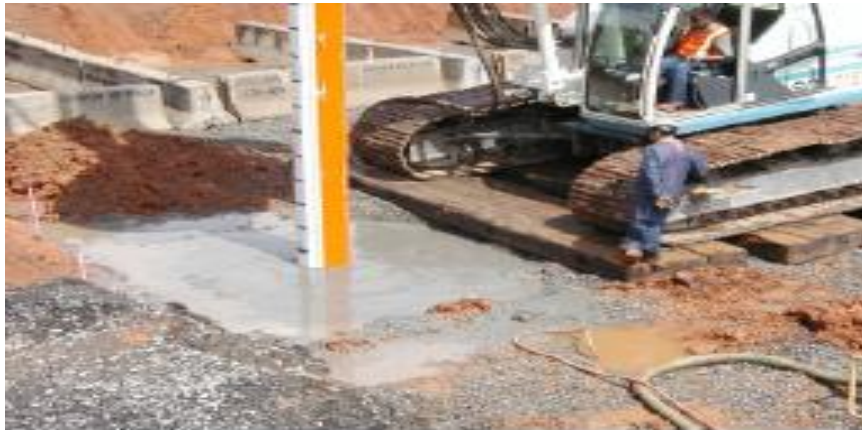
Figure I.10 : Vue de l'outil est ancré dans le sol.
