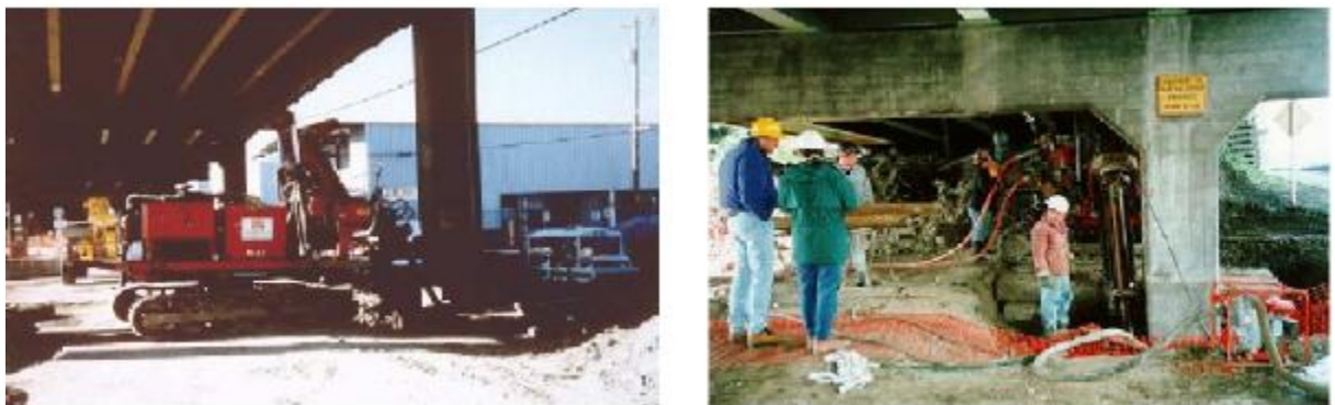
Figure III.6 : réalisation du renforcement de deux ponts avec de micro-pieux
