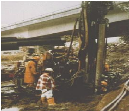
Pont sur l'autoroute I-110 à USA (FHWA 2000).
