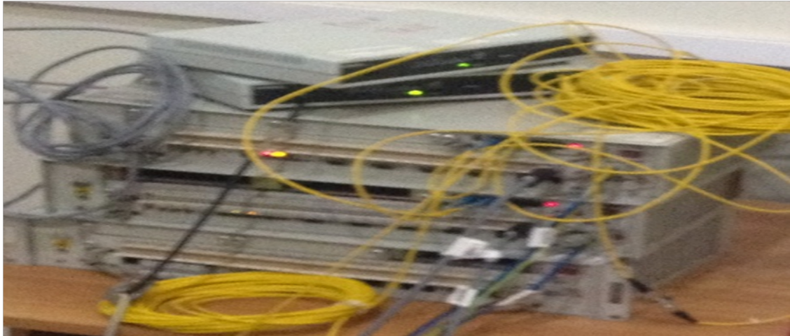
Figure 3.8 – Réalisation de la liaison de transmission de données optique.
