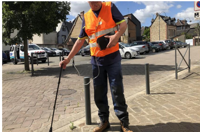
Figure I.6: Recherche systématique des fuites de gaz.
