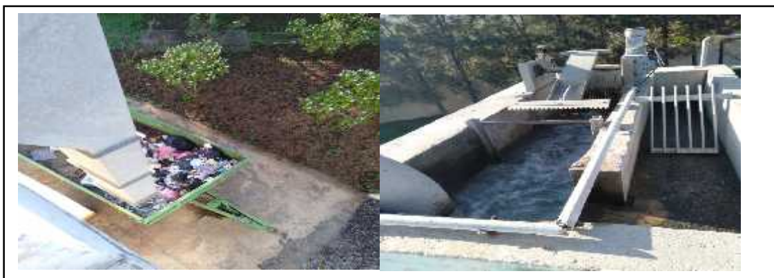
Figure07: Benne des déchets.
