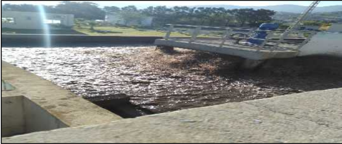
Figure 11: Bassin d'aération et aérateur de surface.
