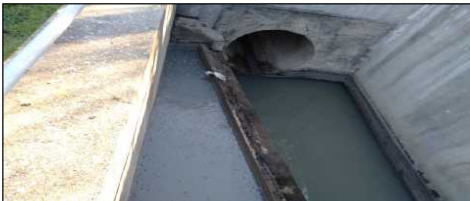
Figure05: Arrivée des eaux et déversoir d'orage.
