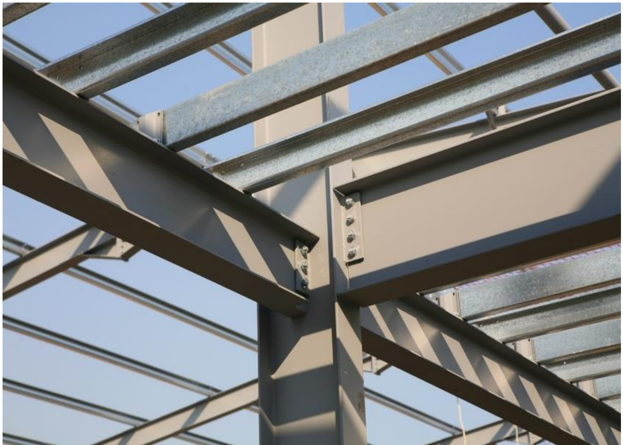
Figure2.1 exemple de poutres en acier IPE
