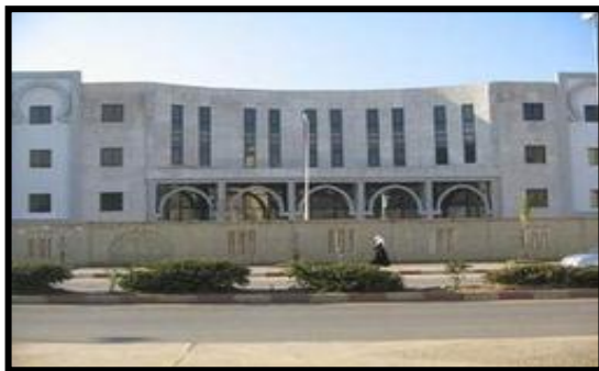
Photo 17 : la bibliothèque de Bab Ezzouar Source : auteurs
