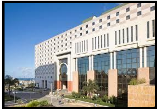
Figure 80 : façade principale d' Hôtel Sofitel Source : www.Sofitel.
