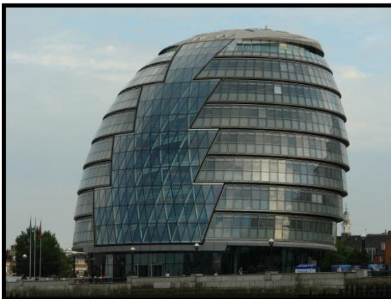
Figure 90: façade de l'hôtel de la ville de Londres Source : www.hotel-ville-de-londres.com
