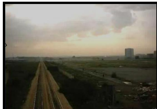
Photo 04 : Chemin de fer Source : auteur
