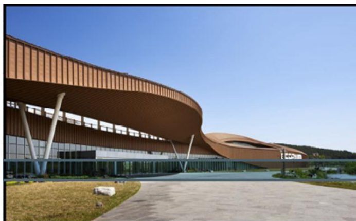
Figure 89: La toiture du le centre .
