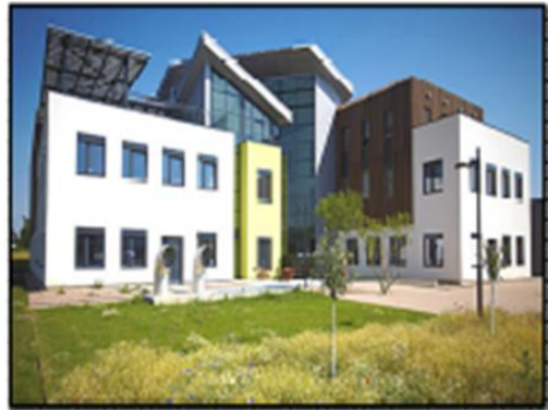
Figure 95: Cité de l'Environnement de Saint-Priest.
