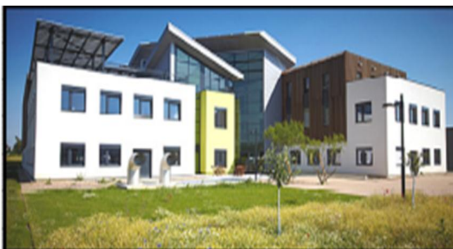
Figure 93: Cité de l'Environnement de Saint-Priest .
