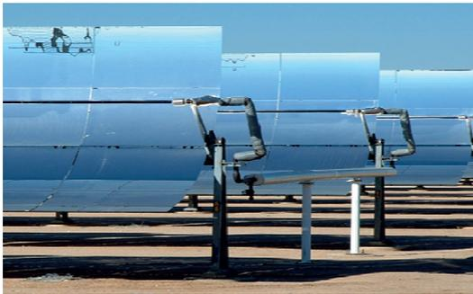
*Capteurs thermodynamique cylindro-paraboliques*
