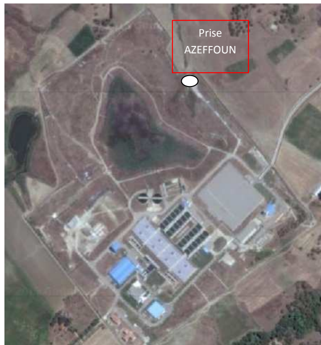
Figure I.5 : la station de traitement[14]
