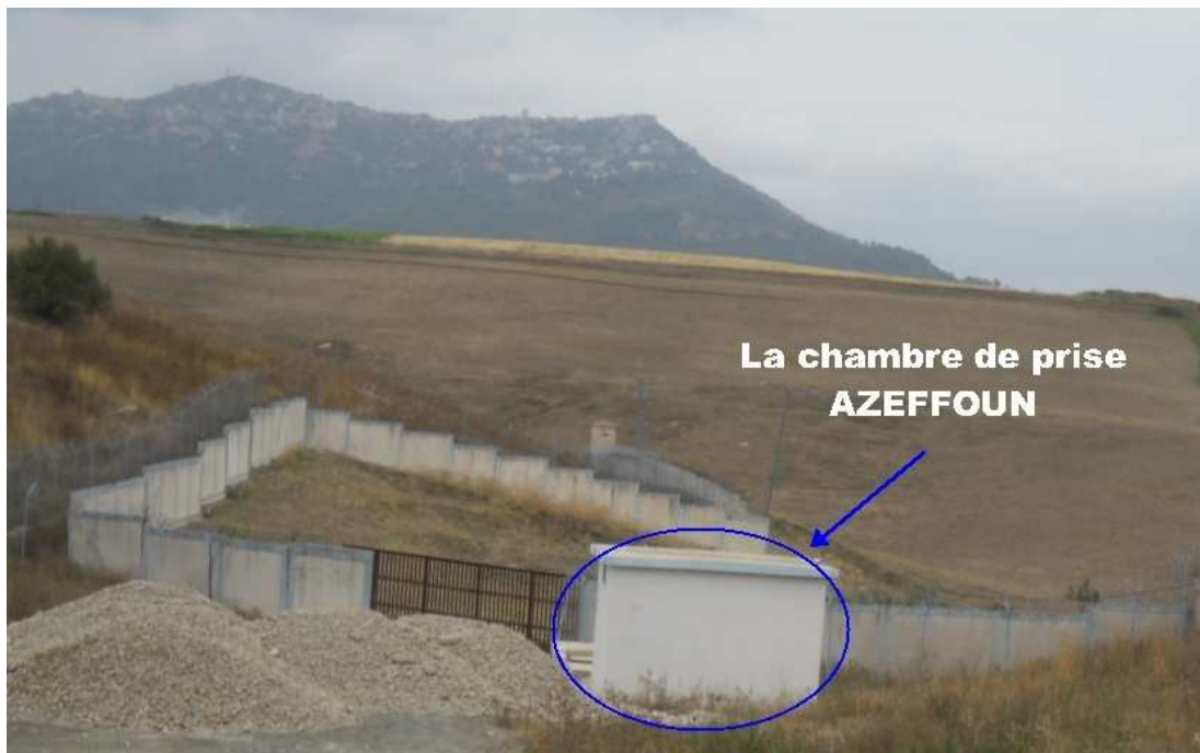
Figure I.8 : Localisation de la nouvelle chambre de prise AZEFOUN
