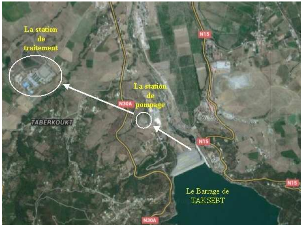
Figure I.3 : Localisation des différentes stations du barrage[14]
