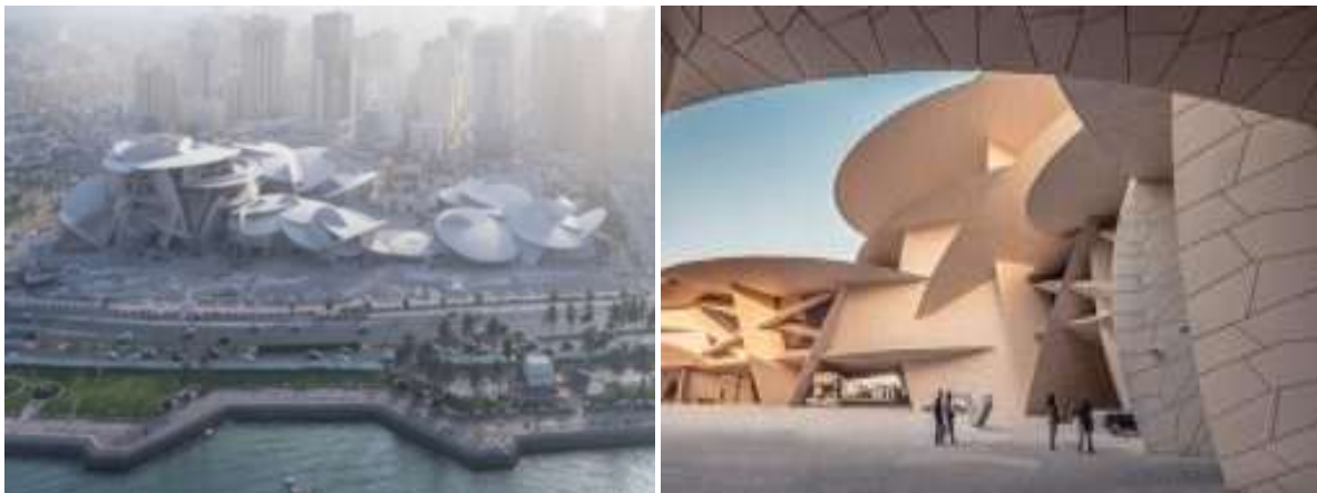
Figure III.4 : Musée national du Qatar réalisé avec du béton armé de textile de verre.[15]
