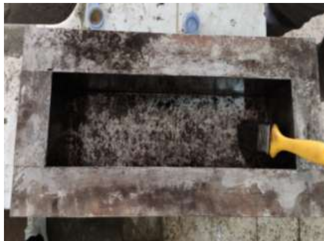
Figure IV.21 : application de l'huile sur les moules métalliques.
