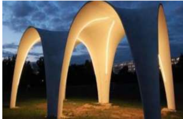
Figure III.3 : Applications TRC-pavillon à TU Chemnitz(Allemagne). [4]
