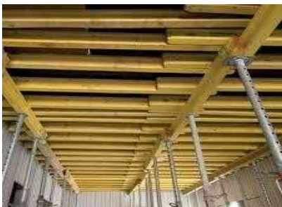
Figure I.8 : coffrage de sol [10]
