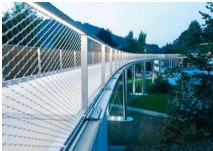
Figure III.5 : Applications TRC-pont à Albstadt-Lautlingen (Allemagne). [4]
