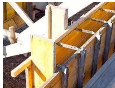
Figure I.9 : panneau de coffrage [11]
