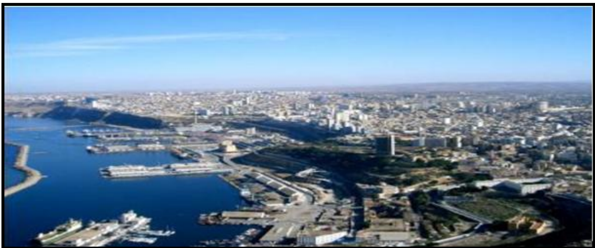
Figure : L'étape de l'aménagement de la baie
