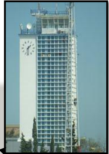
Tour de control
