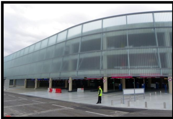
Figure 85: Parking aéroport Nice cote d'Azur Source : http://www.tourmag.com .consulté le 16/05/2017 à 23.59.
