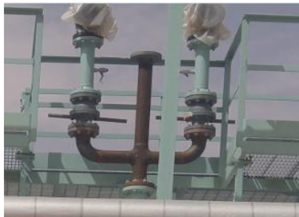
Figure 3.19 : Soupape de sécurité
