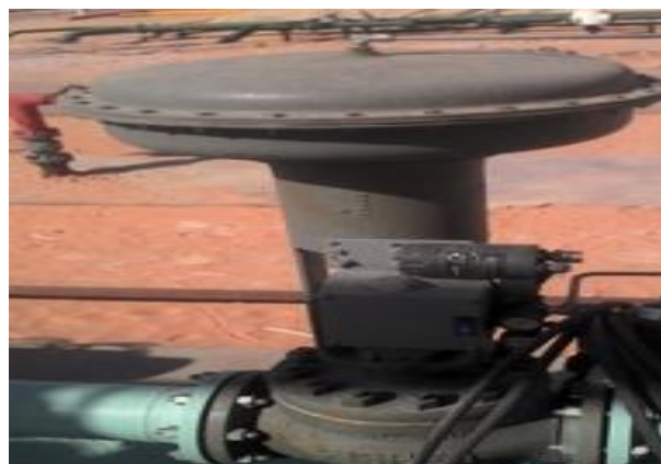
Figure 3.16 : Vanne régulatrice de pression PV
