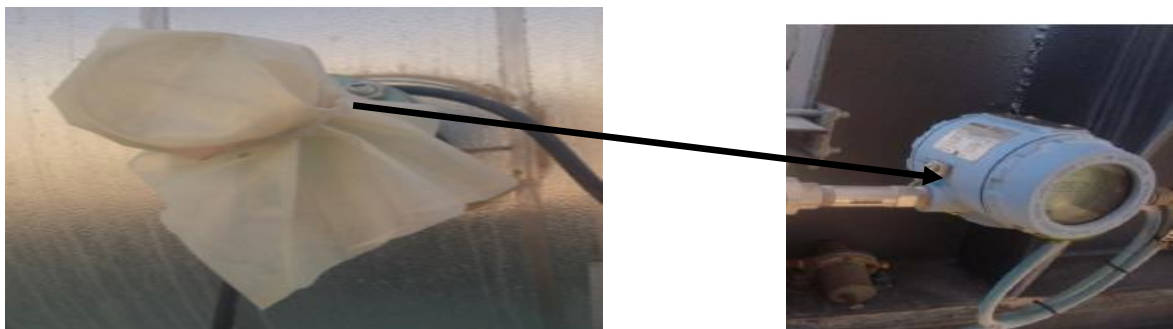
Figure 4.8 : l'emplacement de TT au niveau de séparateur
