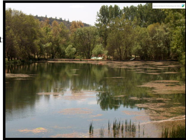
Figure 13 bassins de décantation
