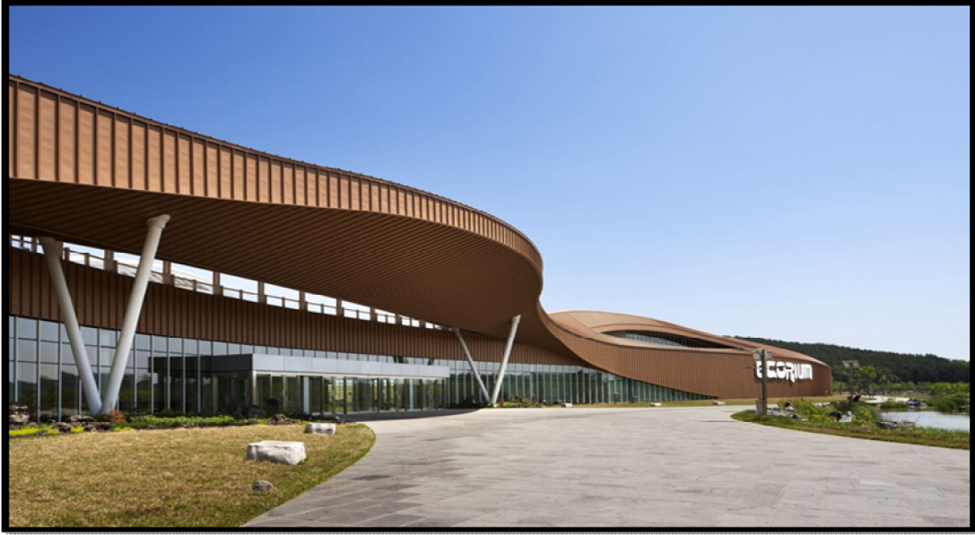
Figure 4: la toiture du le centre Ecorium
