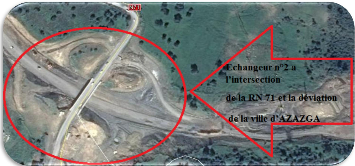
Figure.VII.3 : La réalisation d'un échangeur en trèfle + un Dalou (la RN71) avec la déviation de la ville d'Azazga
