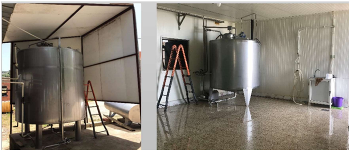
Figure N° 22 : cuves isotherme de 3000 et 6000 litres (photo originale)
