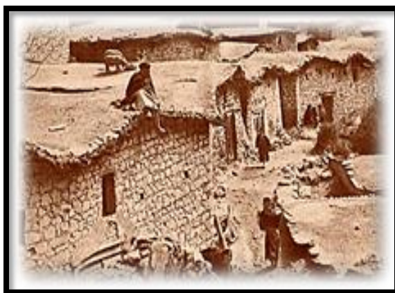
Fig 57 : Toiture terrasse village Agouni Guegherane
