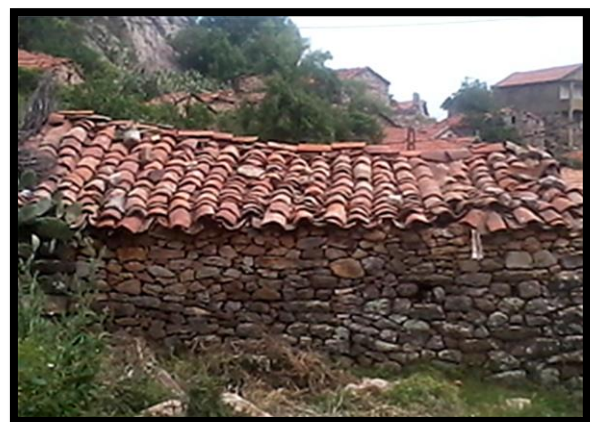
Fig 58 : Charpente de maison du village Voumensour
