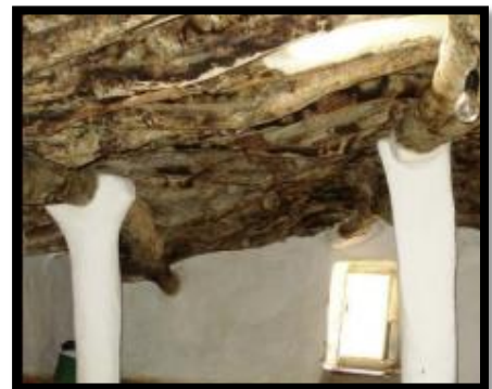
Fig 66 : Asfalou (Ouverture de la toiture)
