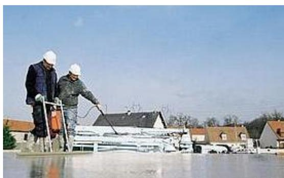
**Figure 5.10** : Application immédiate du produit de cure après le coulage.
