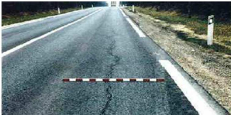
Figure I.11 : Fissures longitudinales [49].
