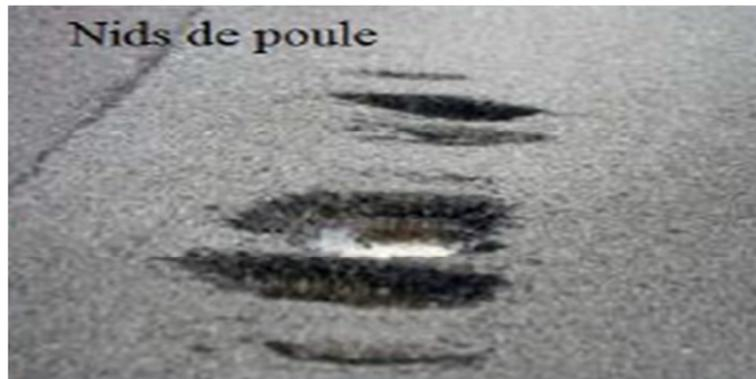
Figure I.13 : Nid de poule nécessitant un bouchage d'urgence
