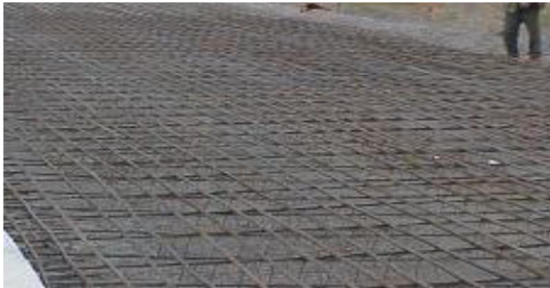
Figure I.6 : Armature filante d'une chaussée en béton armé.
