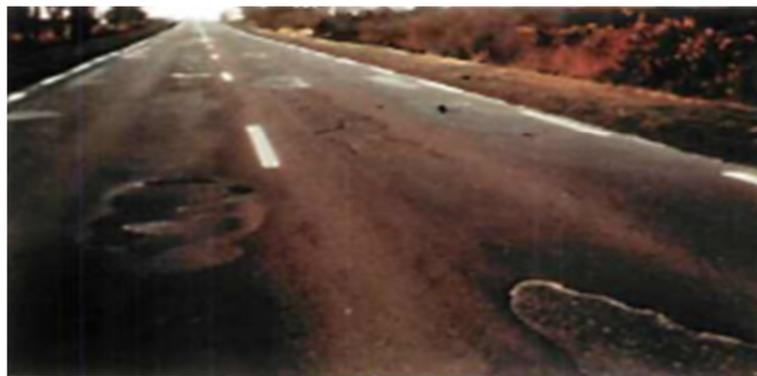
Figure I.14 : Pelade sur enrobé de faible épaisseur [44].
