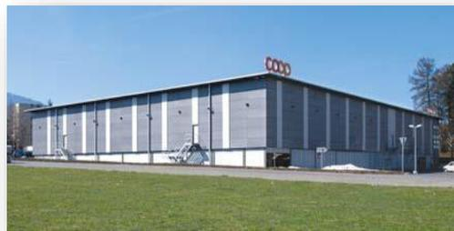
**Figure 161: façade lisse, ventilée avec granit et tôle**, source: <https://architectes.ch/fr/architectes/bulle/atelier-d-architecture-a3-sa/centre-commercial-coop-le-caro>
