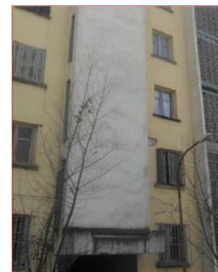
Figure 56: percement latéral de la cage d'escalier
