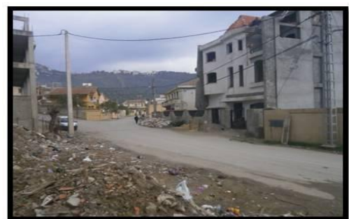
Figure 111 : photo de la paroi Source : auteur
