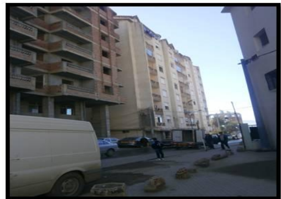
Figure 77 : parois de la voie Source : auteurs
