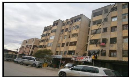
Figure 110 : photo de la paroi Source : auteur
