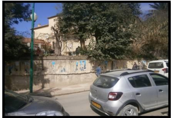
Figure 86: photo de la paroi Source : auteurs
