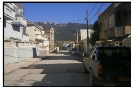
Figure 99 : paroi de la voie Source : auteurs
