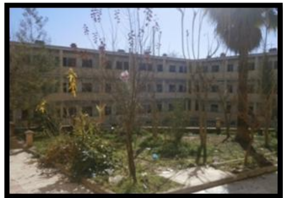
Figure : 44 photo de la cité le cadì Source : auteurs
