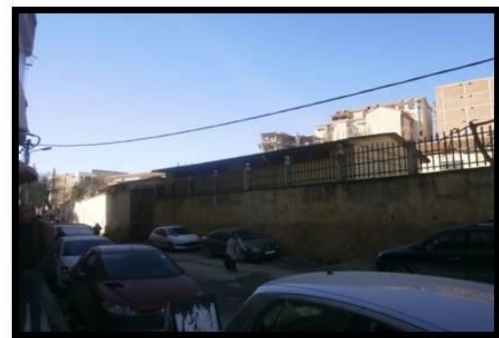
Figure 102 : paroi da la voie Source : auteur
