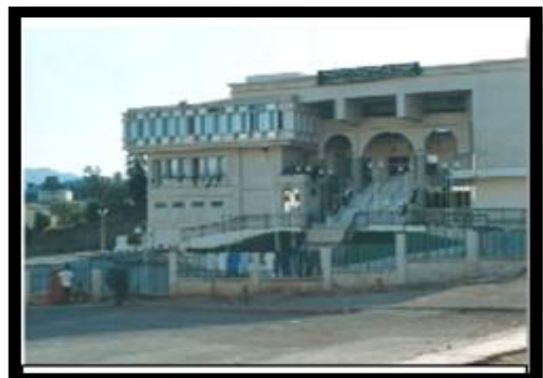
Figure 4 : photo de siège de la wilaya Source : auteurs
