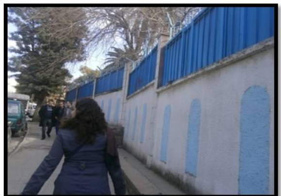
Figure 87: photo de la paroi Source : auteurs
