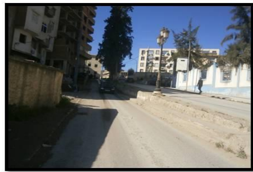
Figure 94: photo de la voie Source : auteurs
