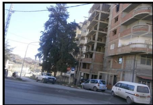
Figure 95 : photo de la voie Source : auteurs
