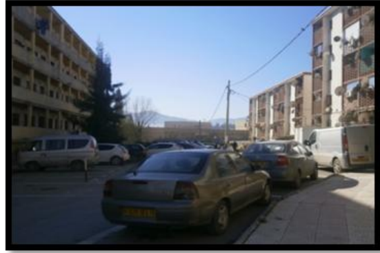
Figure 43 : photo de la cité le cadì Source : auteurs
