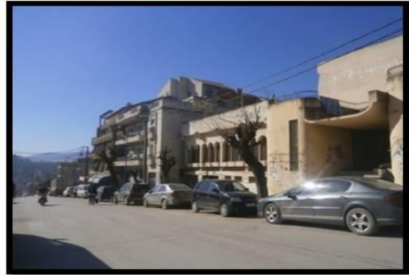
Figure 72 : photo de la paroi Source : auteurs
