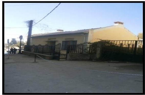
Figure 76 : paroi de la voie Source : auteurs
