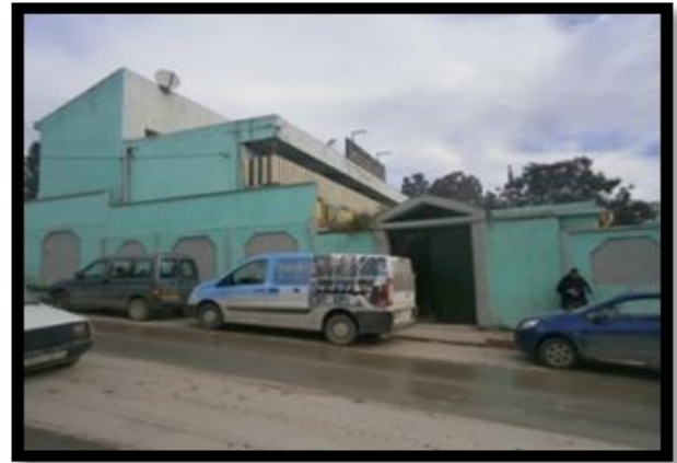
Figure 61 : photo de la direction de l'action sociale Source : auteurs
