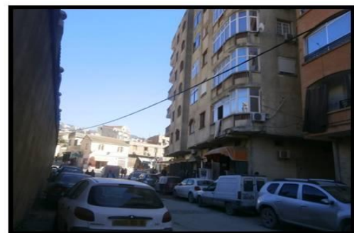
Figure 103: paroi de la voie Source : auteur
